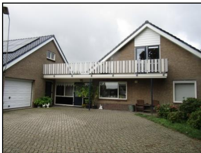
Figuur 3. Zuidelijk gelegen bedrijfswoning.
