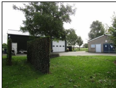
Figuur 4. Zuidelijk gelegen schuur.
