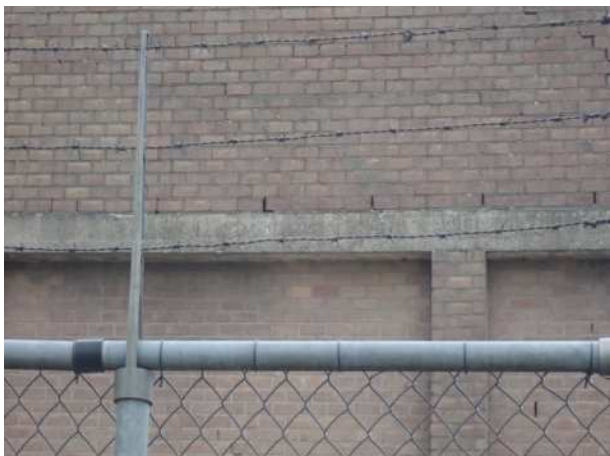
Foto 17: links, zuidgevel met stootvoegen boven de betonnen sloof.
