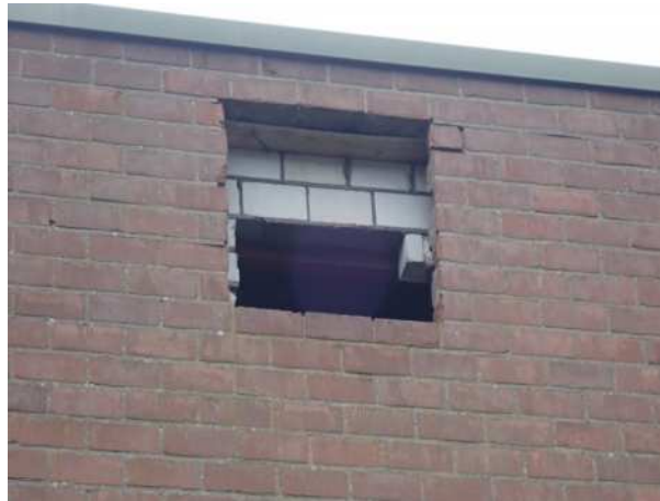
Foto 23: links, de spuwmuur aan de zuidzijde van de loodsen.
