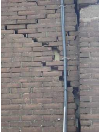
Foto 25: links, brede scheuren aan de noordzijde achter de te behouden bedrijfswoning
