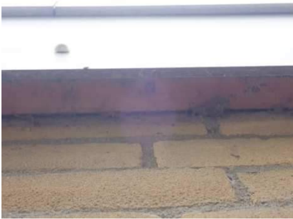
Foto 7: links, detail van de daklijst met de houtenlat strak tegen het metselwerk
