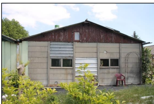
De schuur, foto genomen vanaf de westkant.
