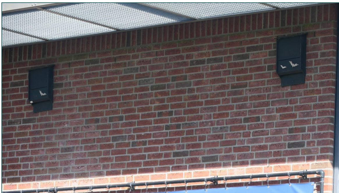
Figuur 3 Impressie van de vleermuiskasten die op gebouw 1 aanwezig zijn. In de beoogde ruimtelijke ingreep zullen deze behouden blijven.
