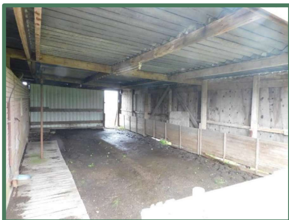
Overzicht binnenzijde aanbouw landbouwschuur plangebied
