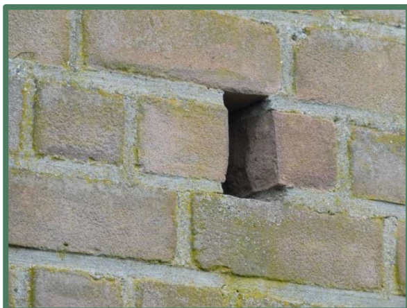
Gat in de wand biedt toegang tot de spouw
