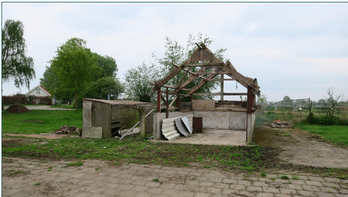
Figuur 2 Weergave van de te slopen stal en kippenhok. Van de stal is het dak reeds gestript.
