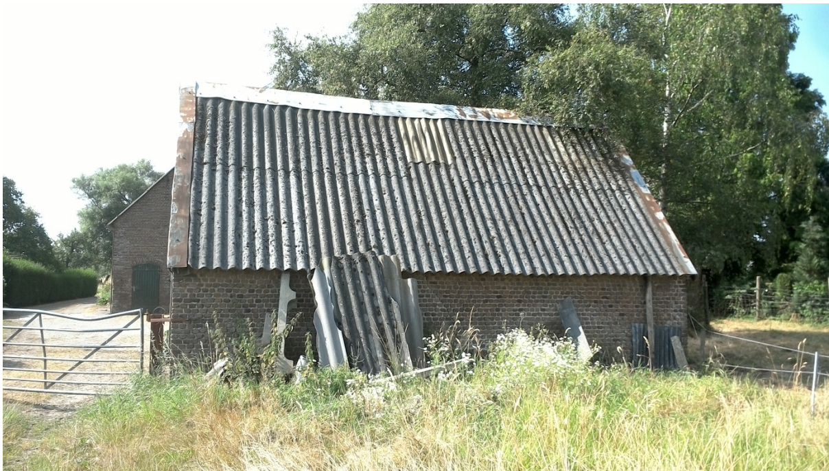
Afbeelding 2: Foto ter plaatse van proefgat 14
