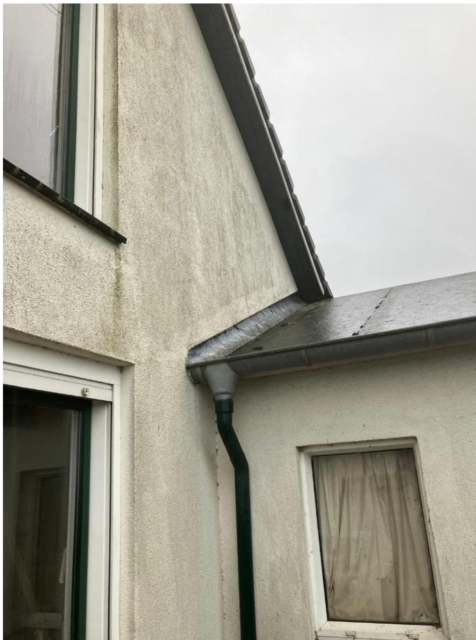
• Afbeelding 31: uitbouw met dak van bitumen die in stucwerk is ingelegd
