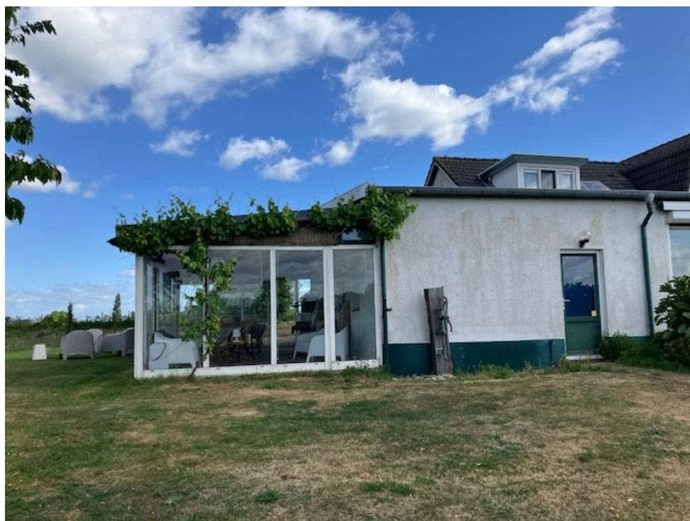
• Afbeelding 15: De serre wordt gesloopt
