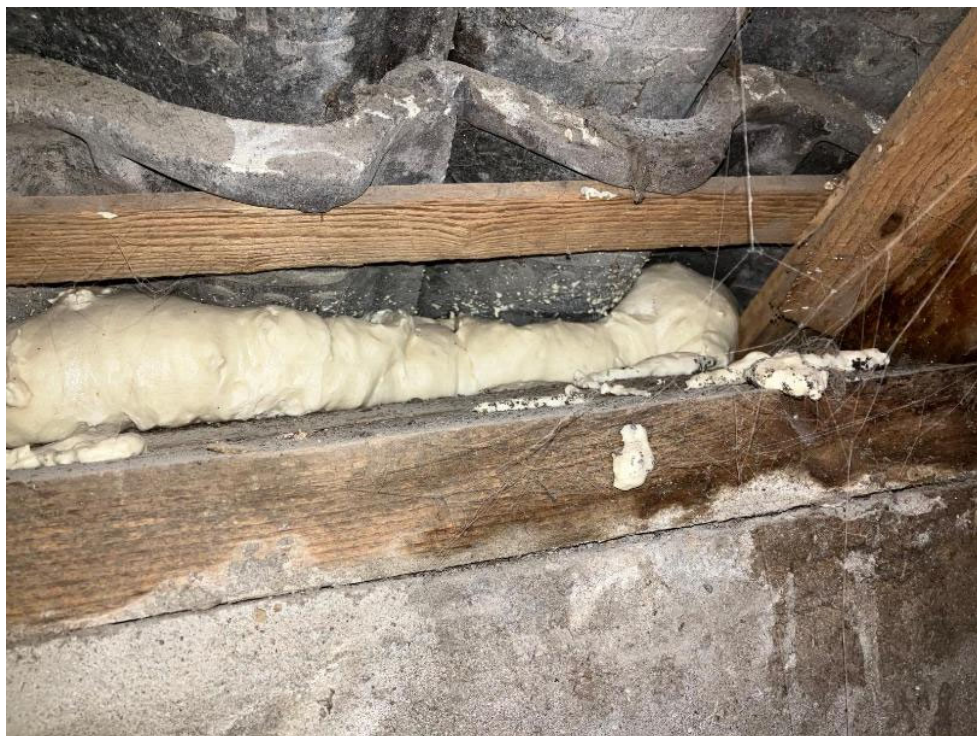
• Afbeelding 23: onderzijde dakpannen, pur op de muurplaat, alle pannen zijn te zien op zolder
