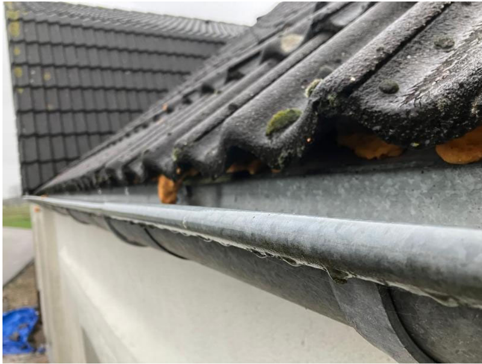
• Afbeelding 28: dakgoot met pur onder de pannen
