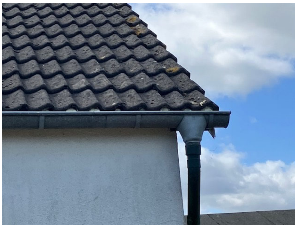
• Afbeelding 9: Onder het dak zit ook pur
