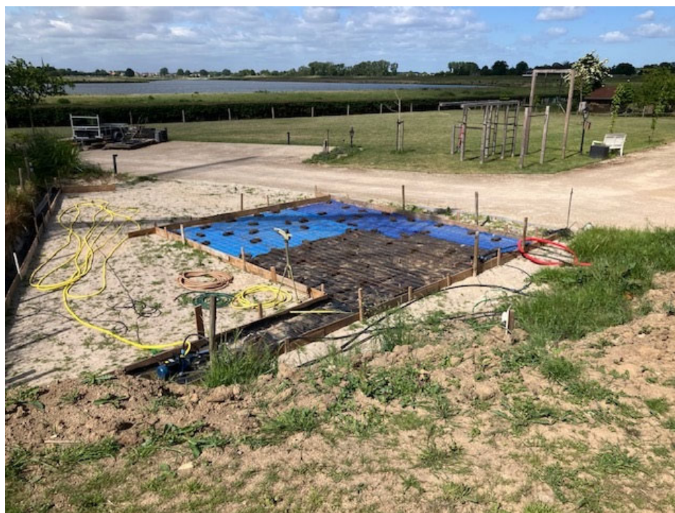
• Afbeelding 13: Op deze plek wordt nieuw bijgebouw gebouwd
