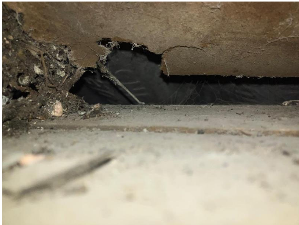
• Afbeelding 22: onderzijde dak
