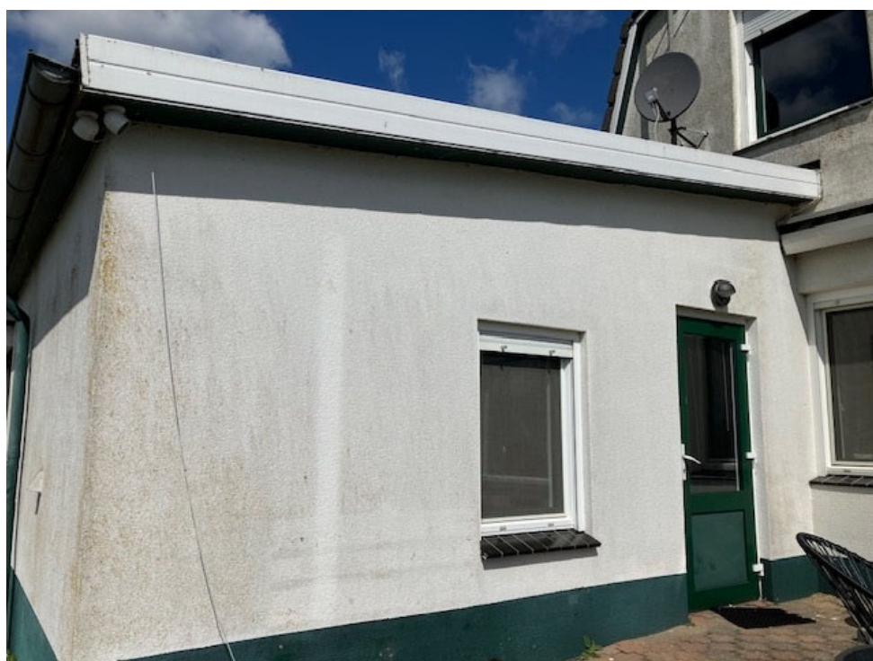
• Afbeelding 19: Aanbouw wordt verbouwd
