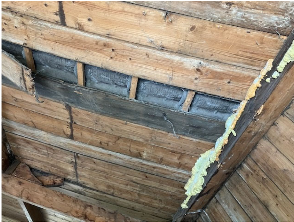
• Afbeelding 6: Gaten zijn met pur dicht gemaakt
