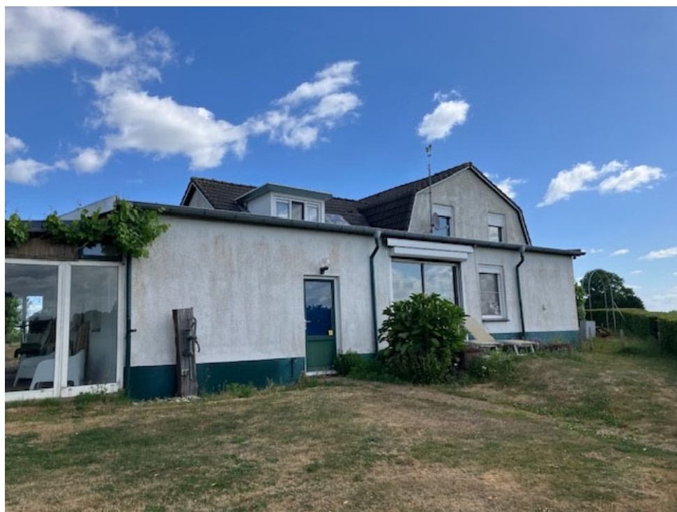
• Afbeelding 14: Het achterste gedeelte wordt verbouwd, de serre wordt gesloopt
