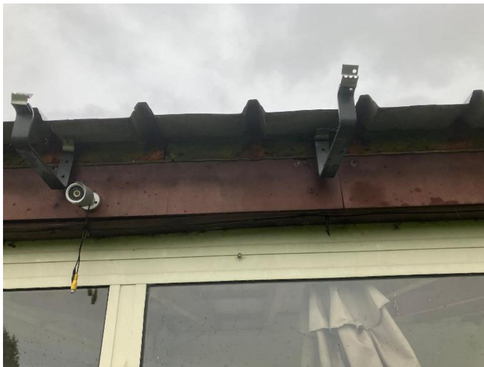
• Afbeelding 30: serre met dak van sandwichpanelen
