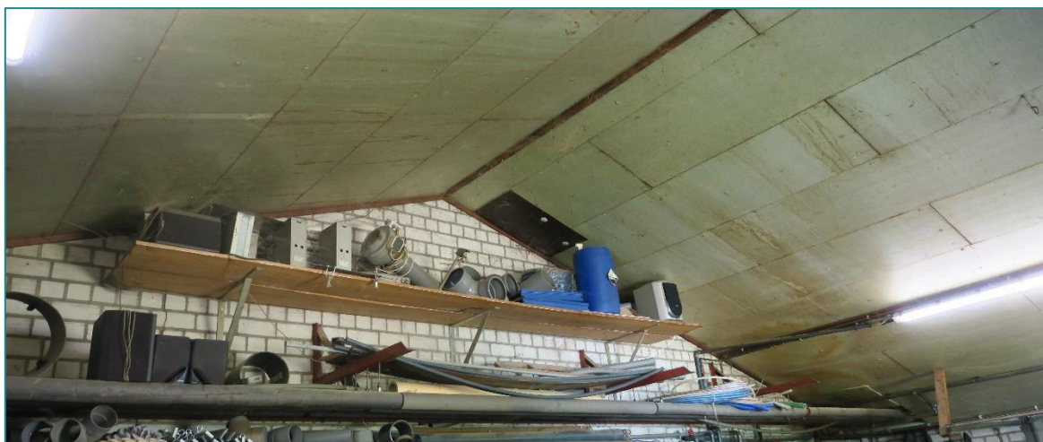
Figuur 3.1 Impressie van het dak met isolatieplaten waardoor de aanwezigheid van dakbeschoot vastgesteld kan worden.
