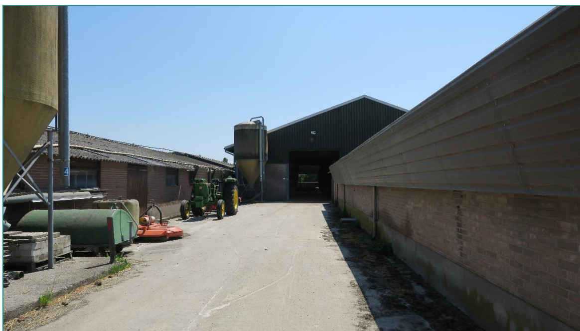
Figuur 2 De bebouwing bestaat uit twee varkensstallen (links en rechts) en een loods (middenachter).
