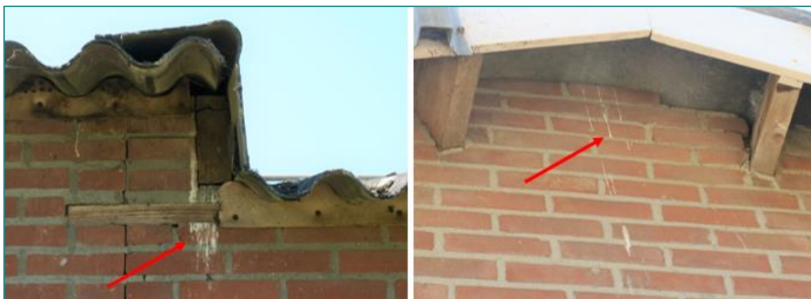
Figuur 3.4 Sporen aangetroffen van vogels die nesten onder de golfplaten.
