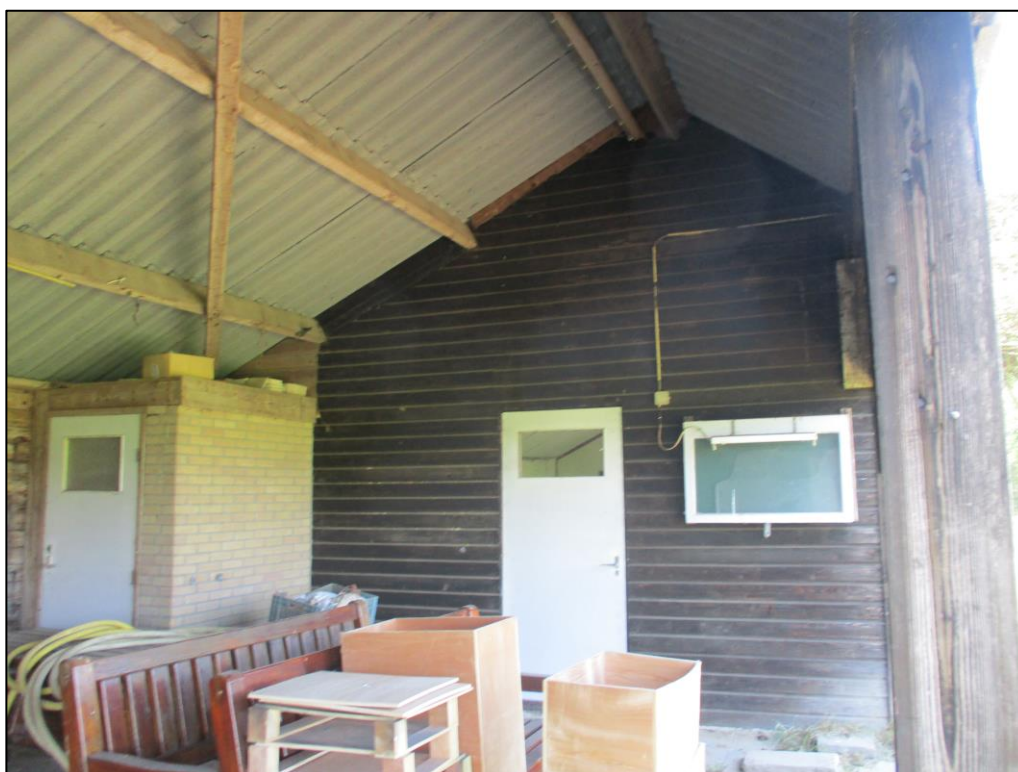
Figuur 3 De binnenzijde van de schuur.
