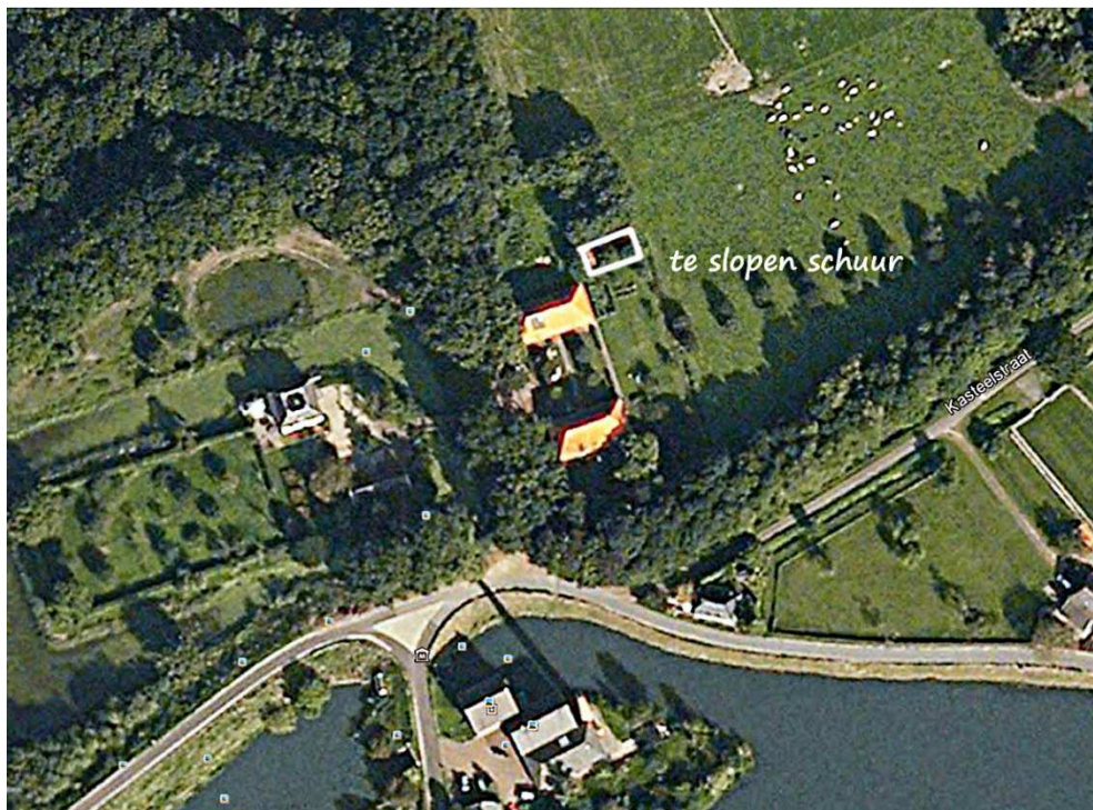
Locatie te slopen schuur
