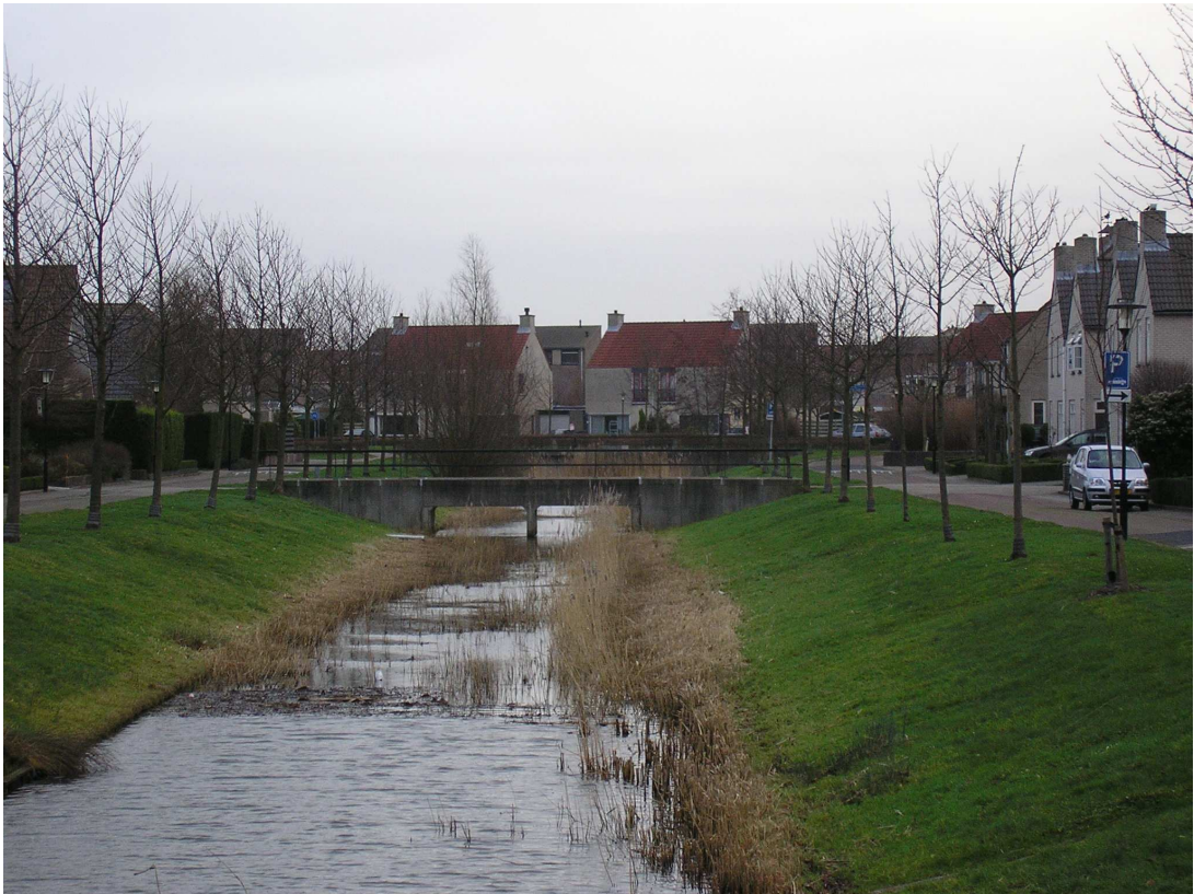
Foto 2: Watergang tussen Chopinlaan en Bachlaan
