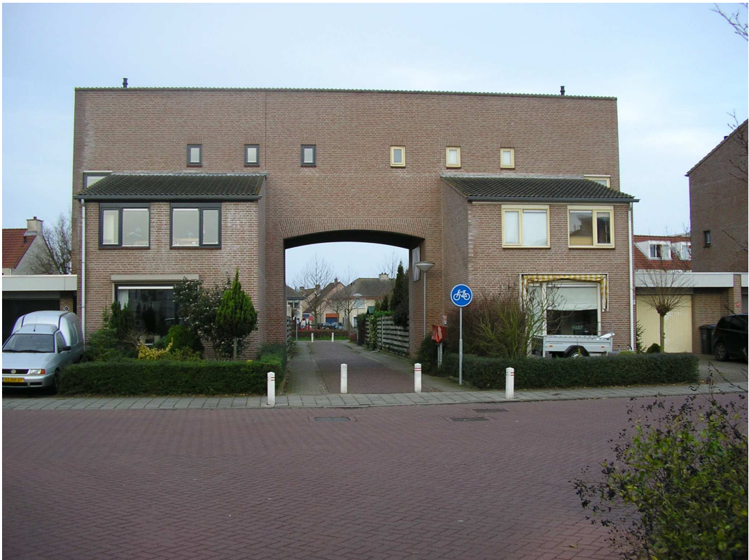
Foto 1: Wand met poort bij de entree aan de Beethovenlaan
