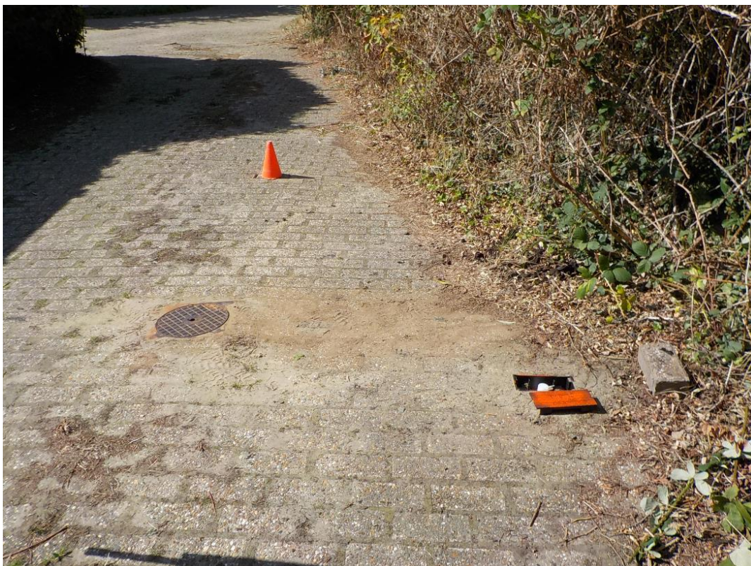
Foto 8 Vulpunt ondergrondse tank
