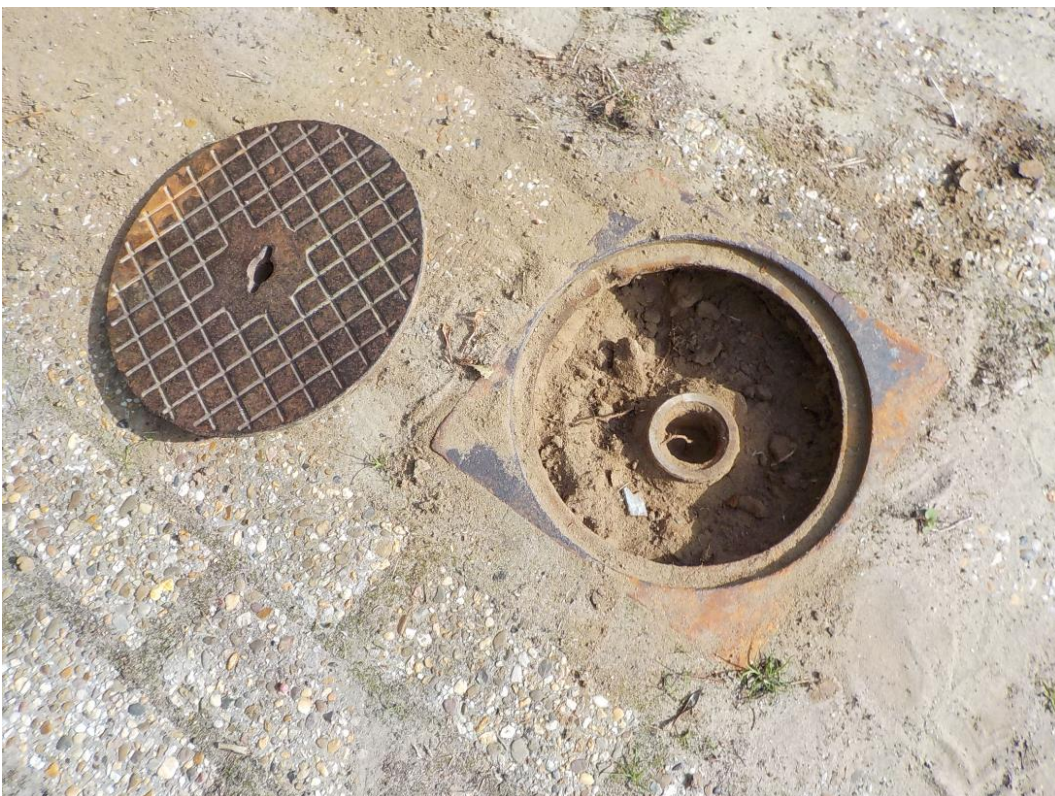
Foto 10. Vulpunt ondergrondse tank
