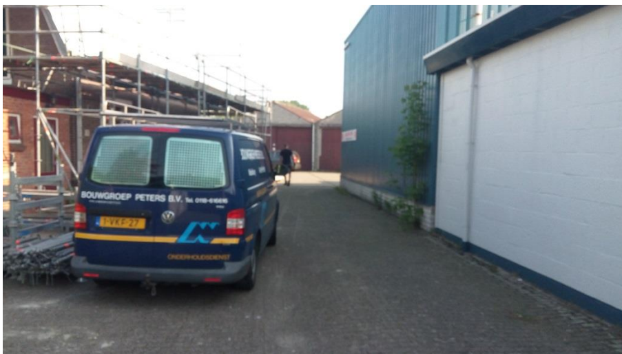
Foto 2. Oostelijk deel onderzoekslocatie tussen huisnummers 22 en 24.
