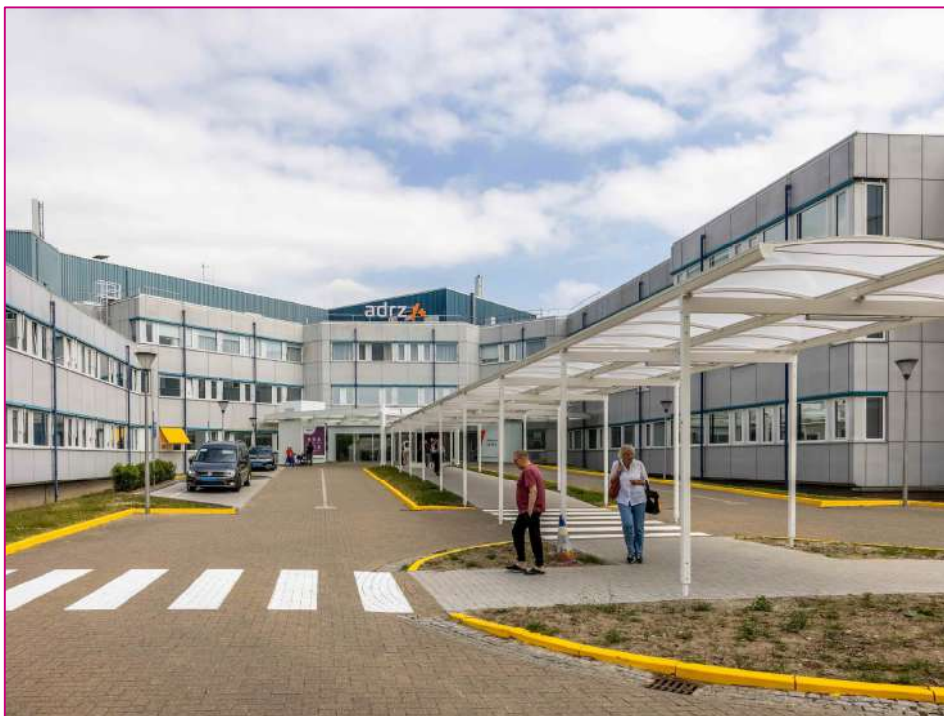
Figuur 2-4 Huidige situatie hoofdentree Adrz (bron: EGM architecten)
