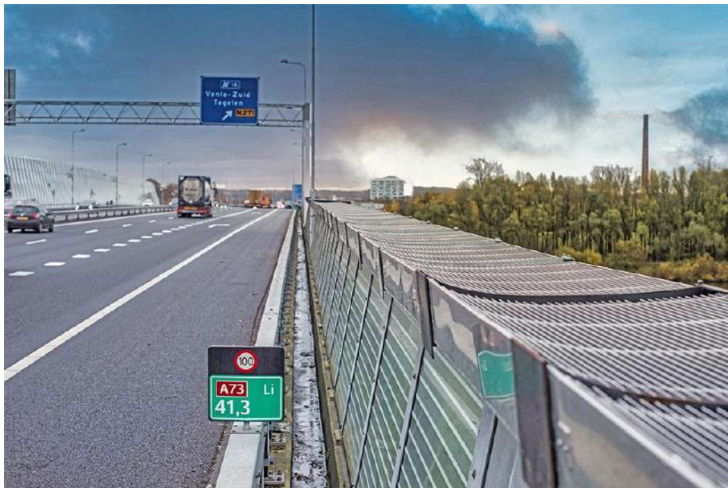
f 5.2 Voorbeeld WHIS® top (diffractor) van 4Silence 3
