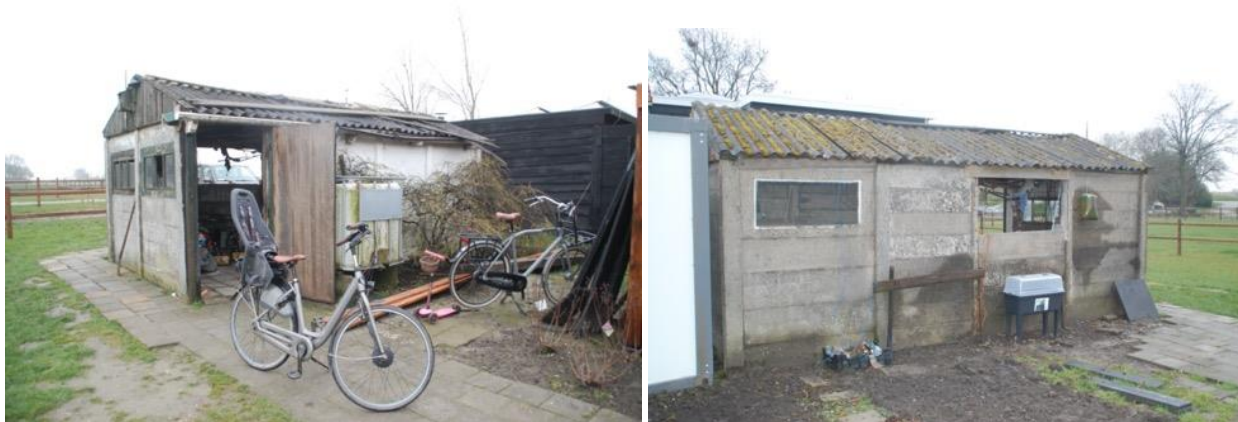
Figuur 4: De opstal (a) van beton en asbest wordt gesloopt.
