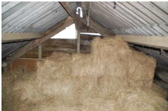
Figuur 13: De zolder van de veestal is toegankelijk maar niet in gebruik door kerkuil of steenuil. Er is geen nestelruimte voor huismussen onder het dak.
