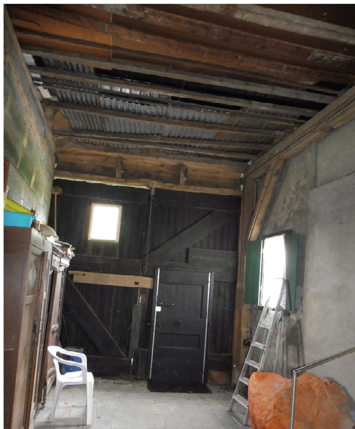
12: eerste travee, mendeuren noordgevel.
