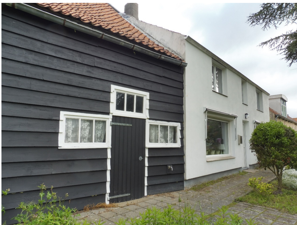
26: deur en vensters zuidgevel eerste travee
