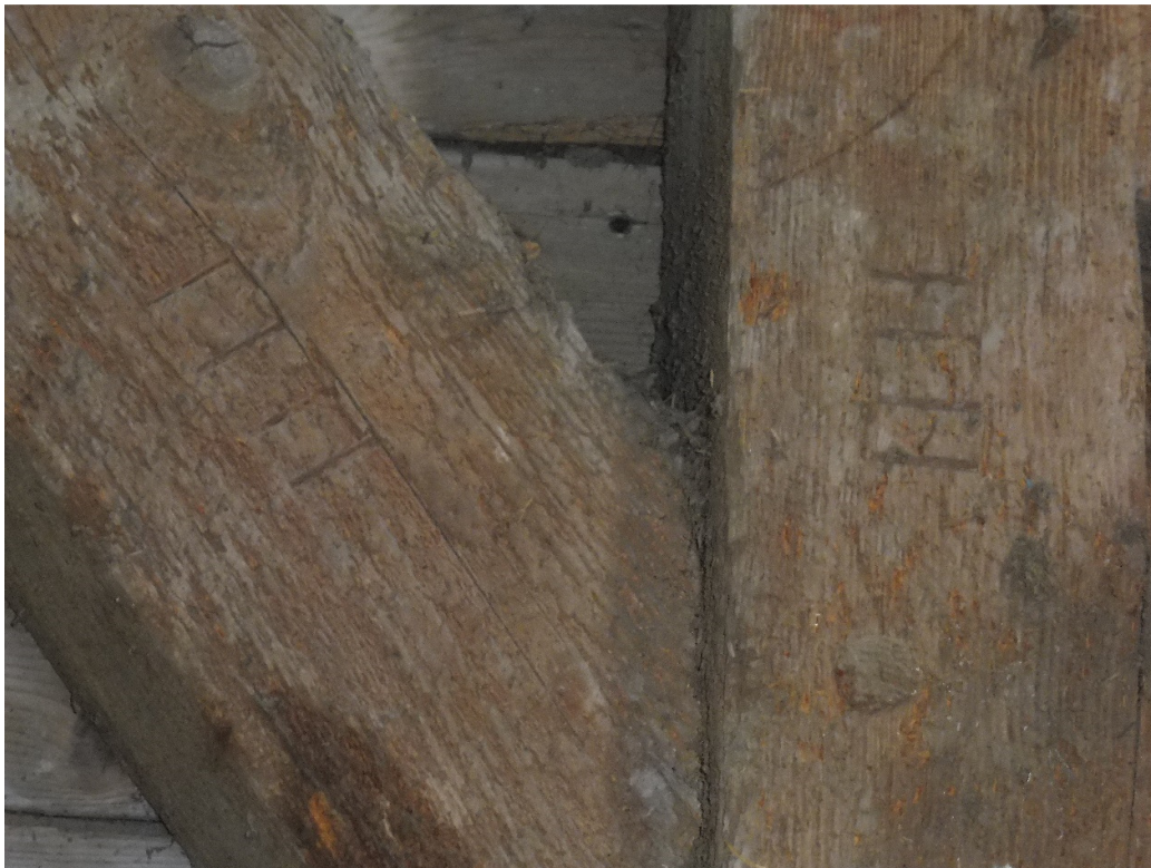
8: montage merken op de gebinten
