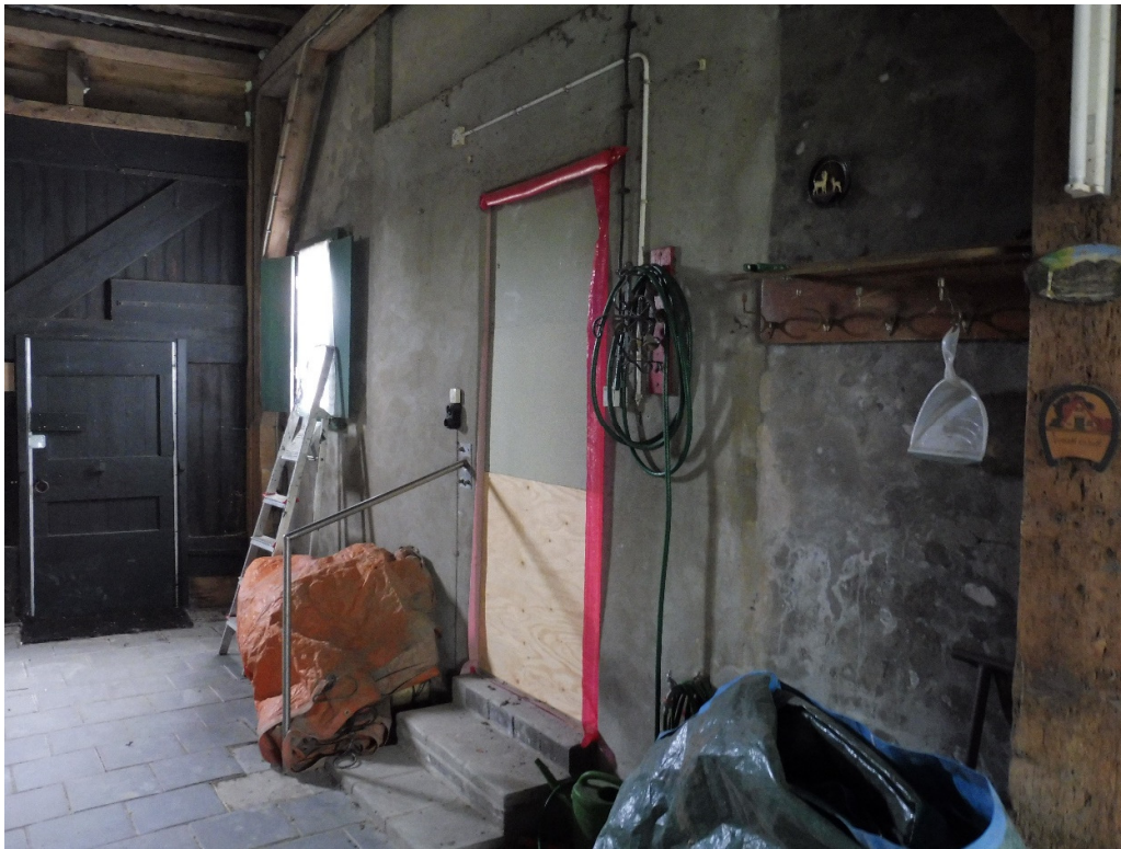
9: woningtoegang eerste travee, noordzijde
