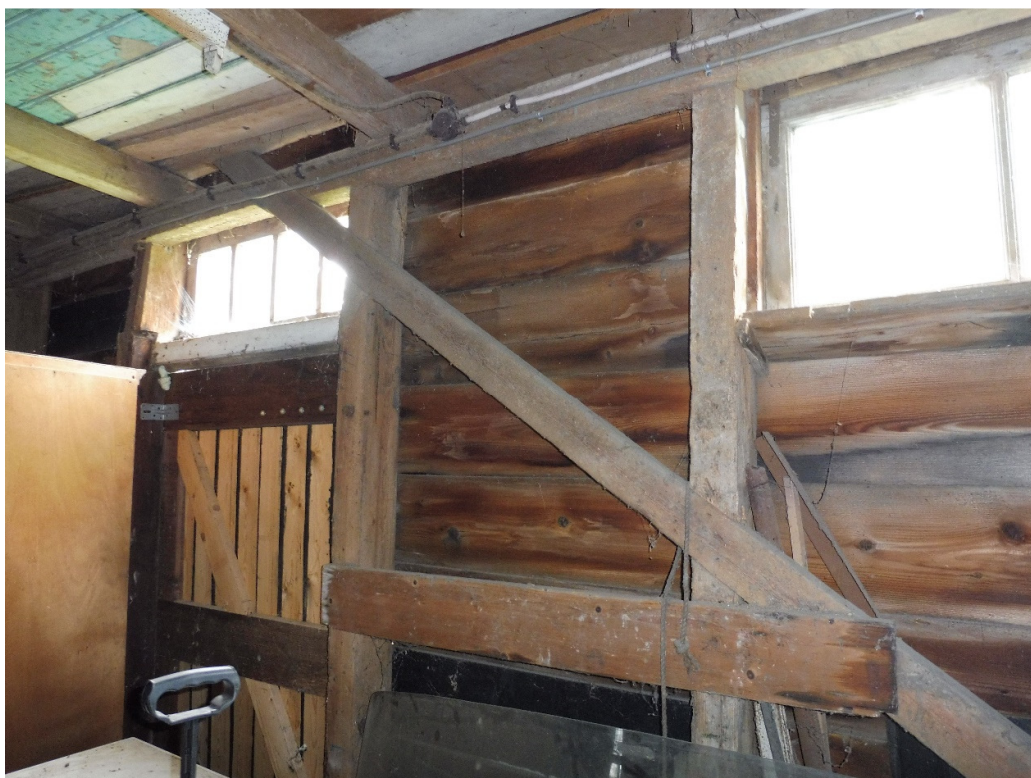
16: vernieuwde staldeur in de tweede travee
