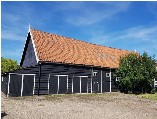
Zuidelijke dakvlak met rode Hollandse pannen en jaartal '1853'
