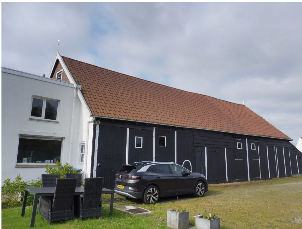
38: hoek woning noordoost met oostgevel
