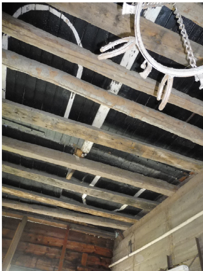
14: slieten constructie boven de eerste travee
