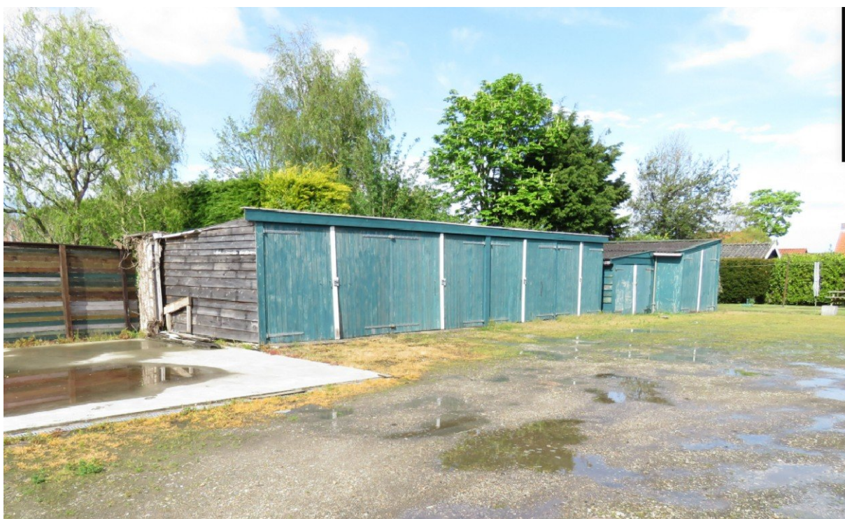
Overzicht van de te slopen bijgebouwen. Foto: G. Tanis | Ecoresult B.V.
