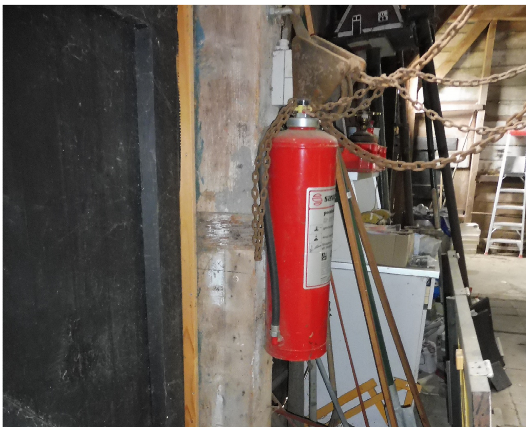
18: gebint 4 naast de mendeuren, spoor van laag schotwerk langs de tasruimte
