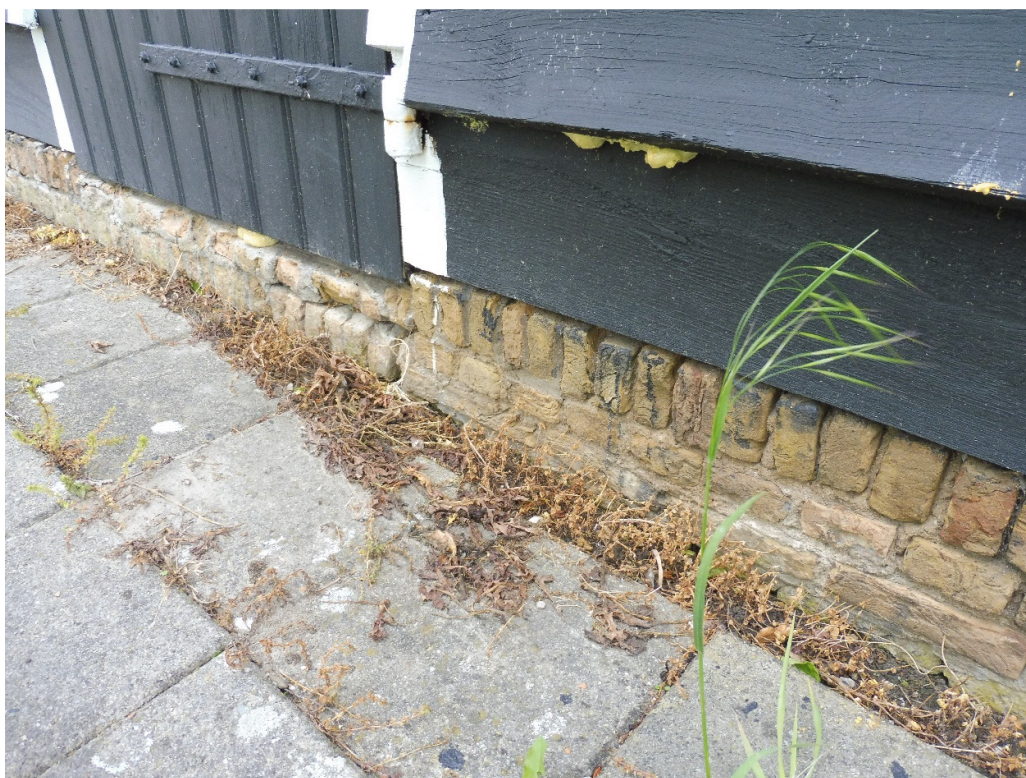
27: voetingmuur zuidgevel rechter gedeelte
