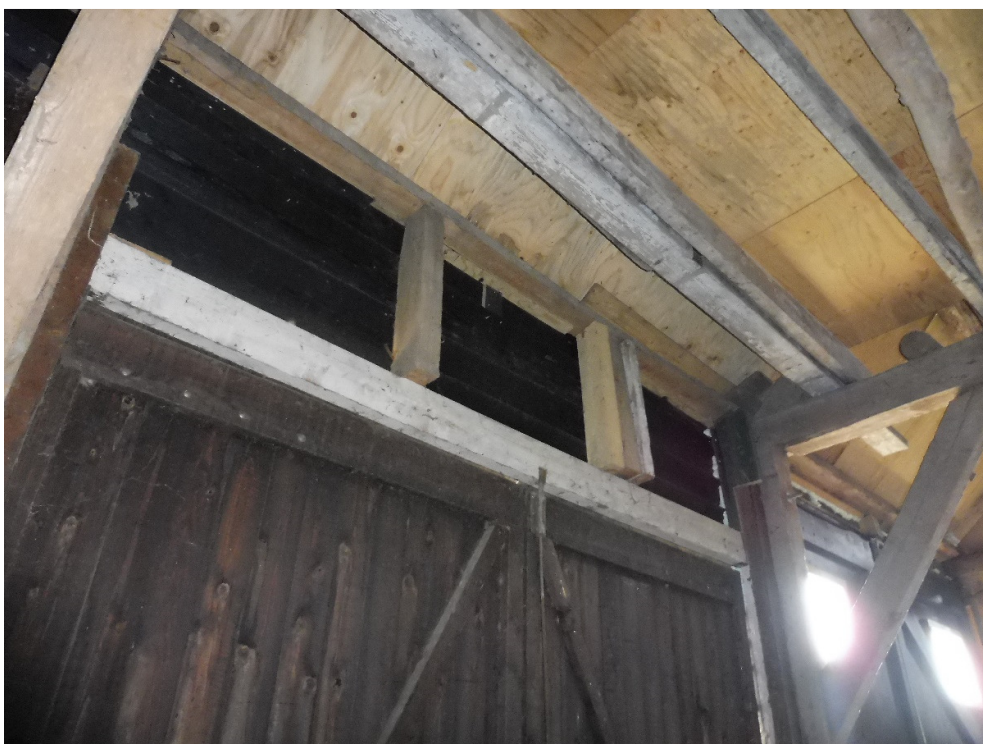
22: vijfde travee noordzijde, gevelaanpassing tbv wagendeuren
