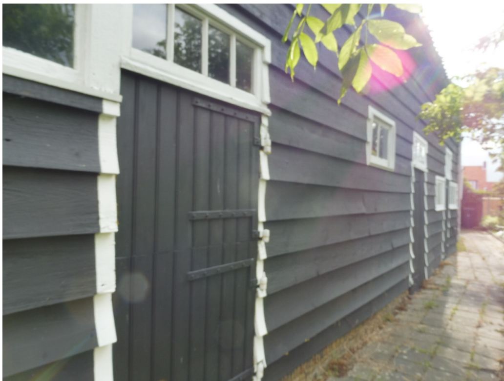
24: zuidgevel rechter gedeelte, staldeuren en ramen
