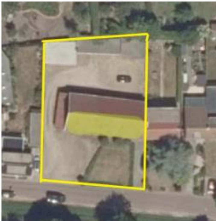
Figuur 2- Luchtfoto van de te slopen bebouwing. De grenzen van het plangebied zijn geel omkaderd, met in het midden de te slopen schuur die aan de straatzijde en linkerzijde is onderzocht op beschermde soorten. Het lichtgroene vlak geeft het dakvlak aan dat geschikt is en als verblijfplaats voor de huismus en de gierzwaluw. Daarom is deel van de schuur onderzocht in het nader onderzoek op het voorkomen van nestplaatsen van beschermde soorten. De volledige schuur is onderzocht op mogelijke verblijfplaatsen van vleermuizen
