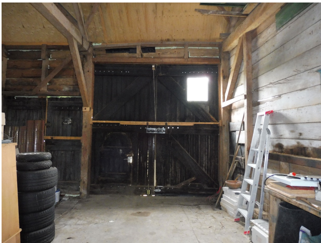
13: tweede travee richting noordgevel, rechts lage taswand met recentere ophoging
