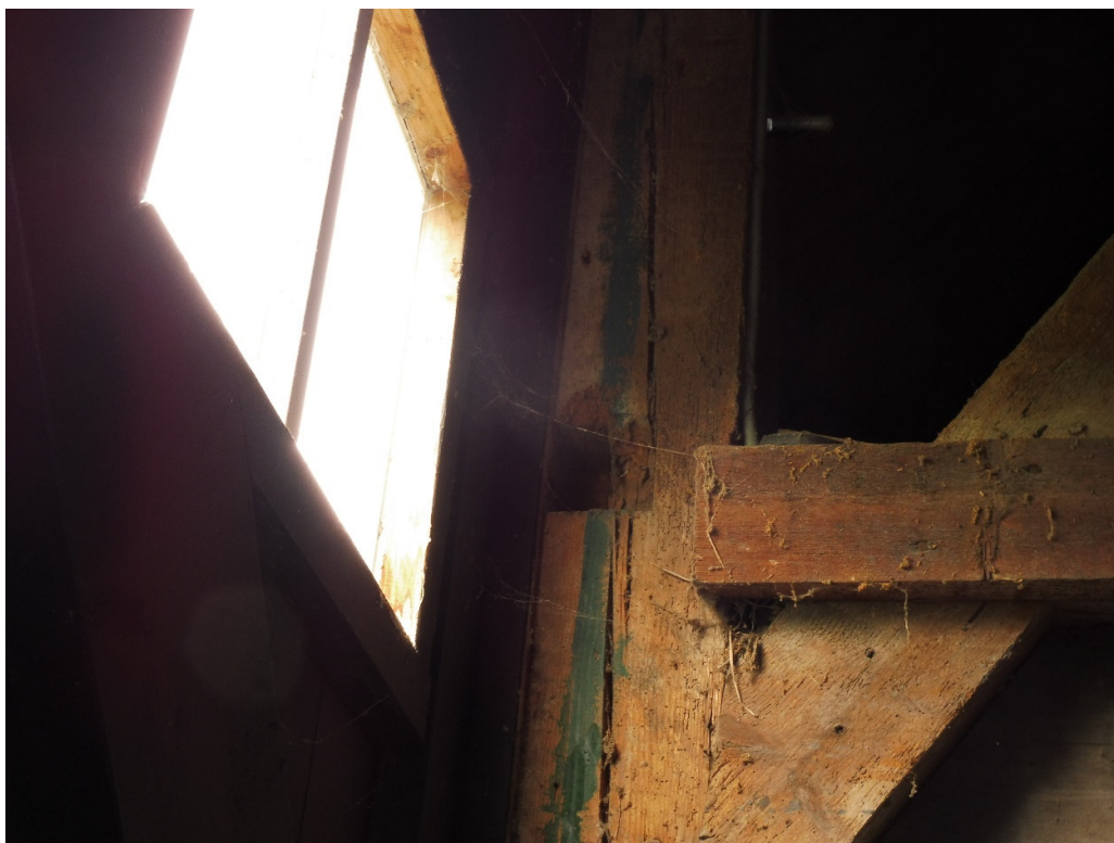
19: gebint 5, zuidzijde, afdruk tussenregel boven de voormalige wagendeuren
