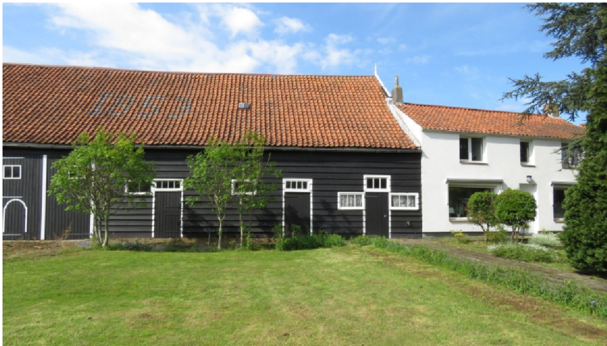
Afbeelding 3: Overzicht voorzijde plangebied. De schuur zal gesloopt worden. Aan de woning rechts zullen geen werkzaamheden plaatsvinden. Foto: G. Tanis | Ecoresult B.V.
