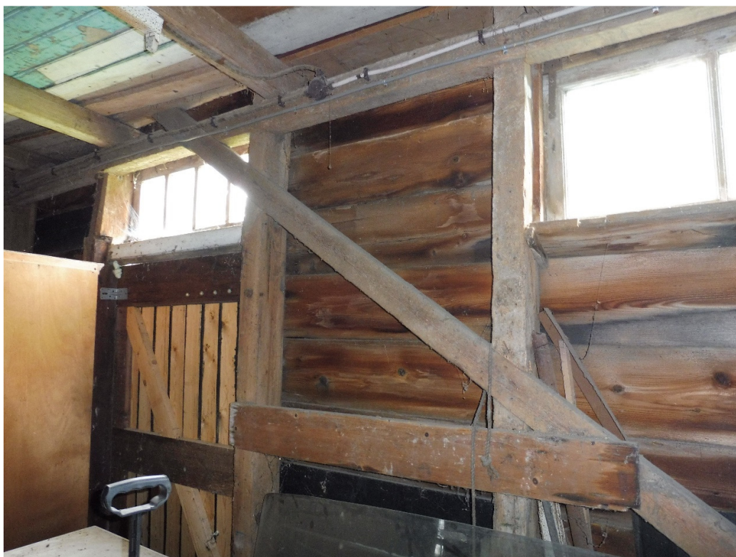
16: vernieuwde staldeur in de tweede travee
