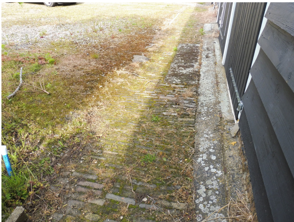
28: zuidgevel, restant meststraat
