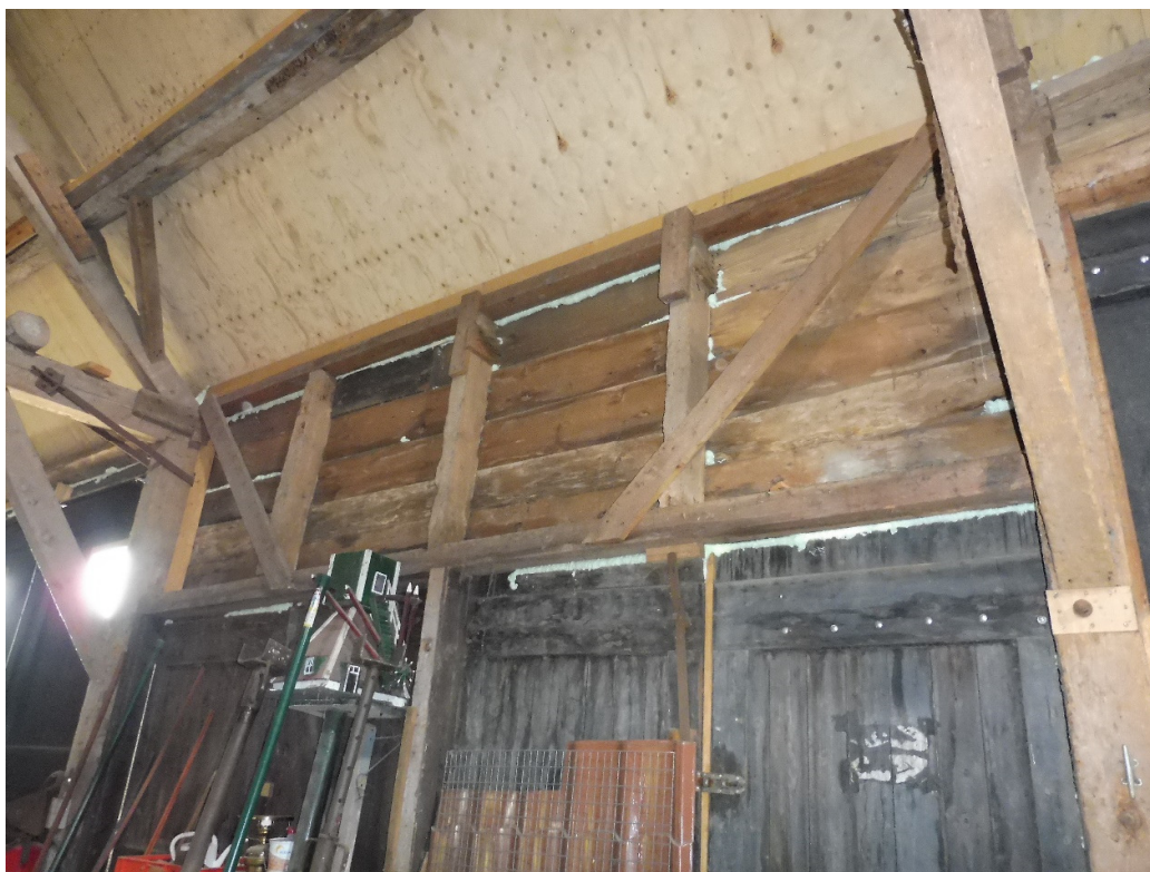
17: wagendeuren in de derde travee , noordgevel
