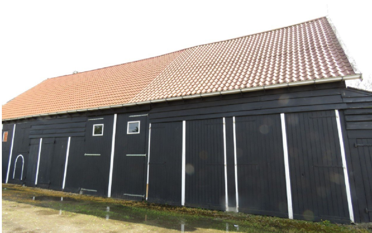
Noordgevel van de te slopen schuur. Foto: G. Tanis | Ecoresult B.V.
