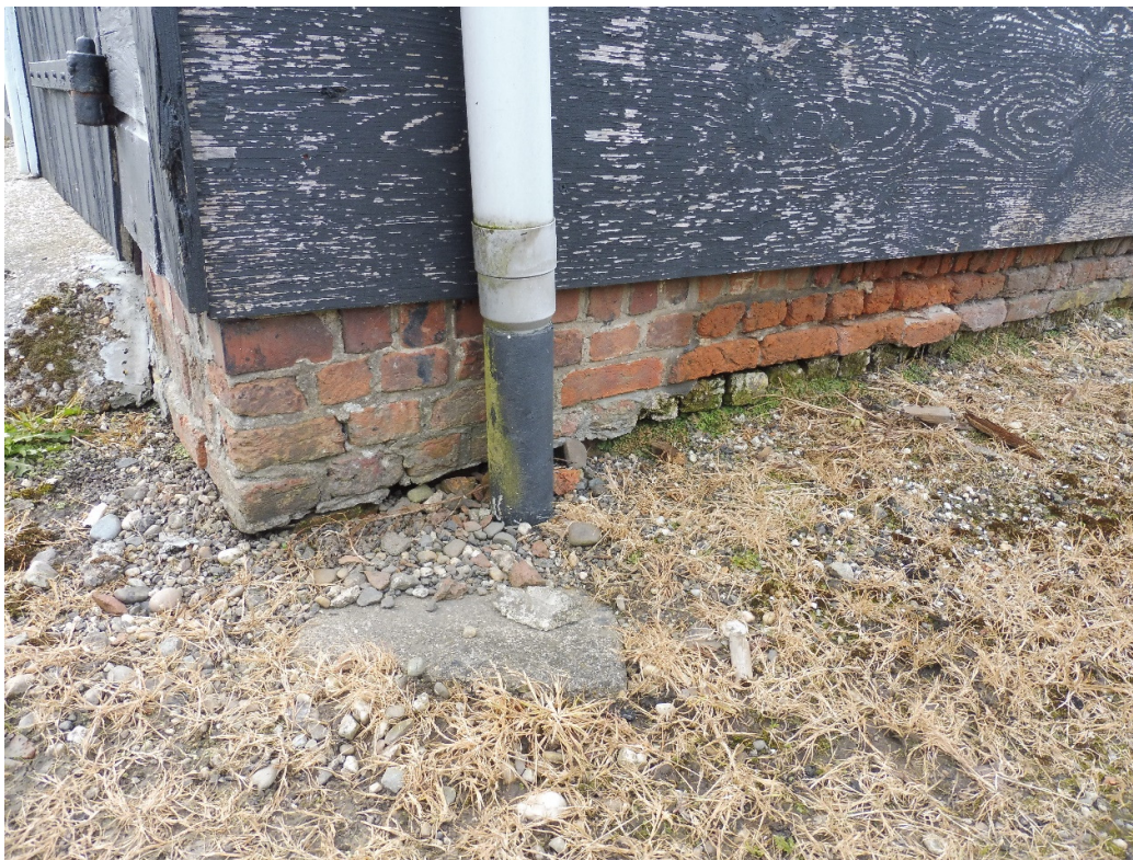
30: voetingmuur aanbouw noord-west hoek
