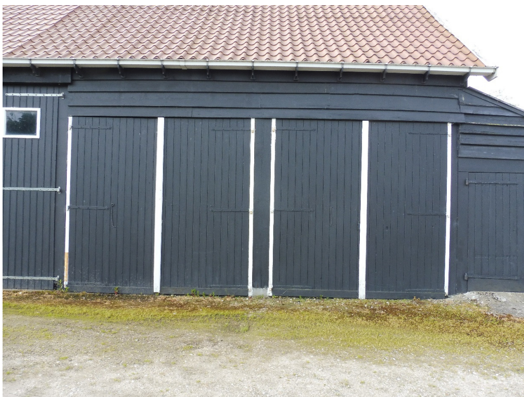
36: noordgevel, vijfde en zesde travee, jonge wagendeuren
