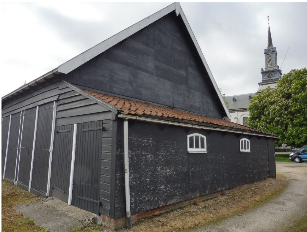
29: westgevels met multiplex beplating
