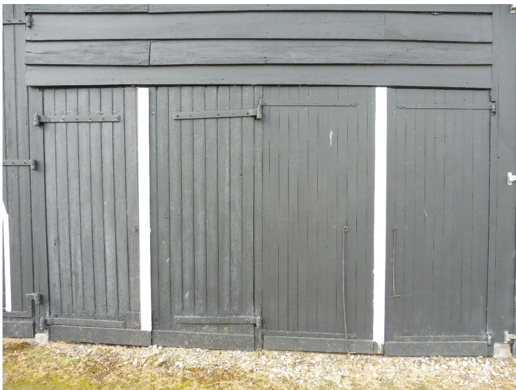
34: noordgevel derde travee, wagendeurstellen, het rechter stel is vrij jong.
