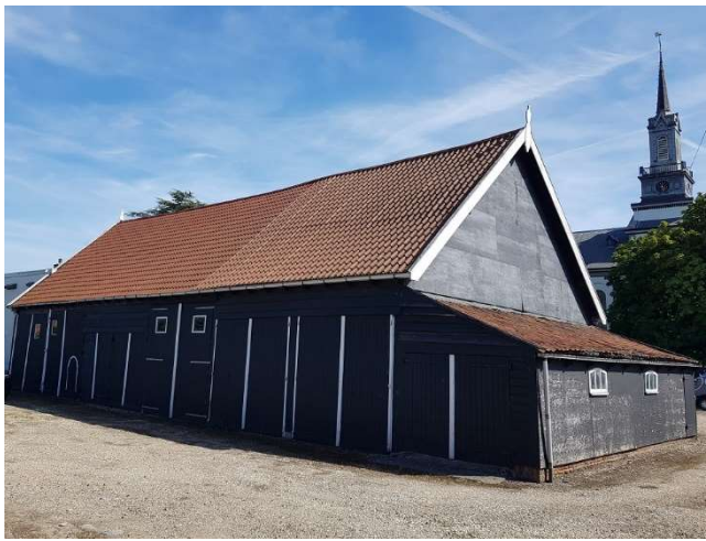
Potdekselwerk, metalen dakpanplaten, multiplex beplating, oude Hollandse pannen
