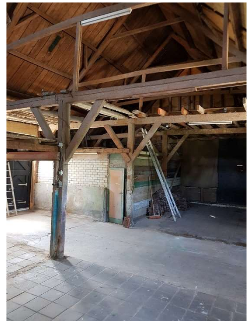
Grenen spanten, gordingenkap, betonvloeren en betontegels
