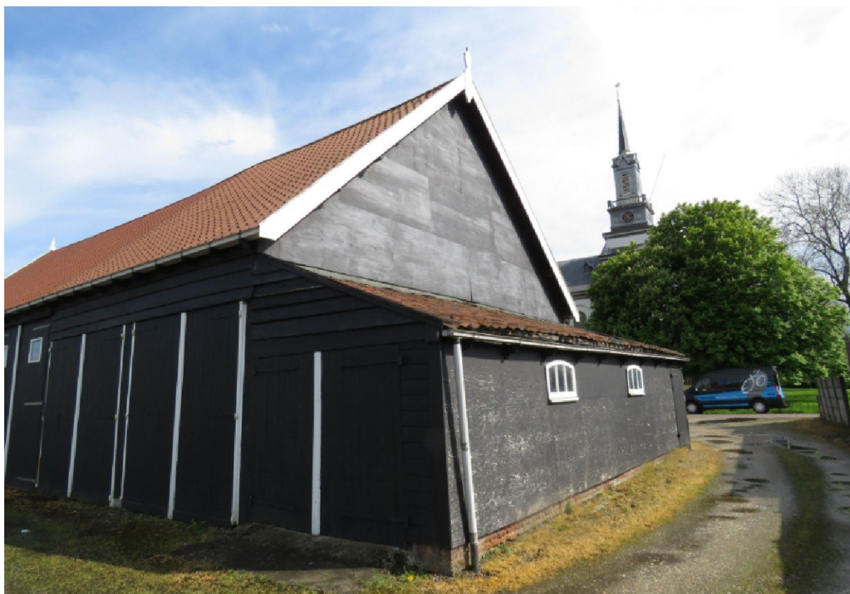
Westelijke kopse gevel van de te slopen schuur. Foto: G. Tanis | Ecoresult B.V.
