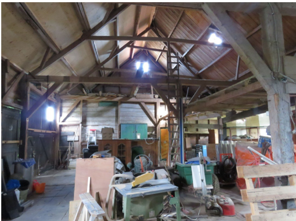
Binnenzijde van de te slopen schuur. Foto: G. Tanis | Ecoresult B.V.
