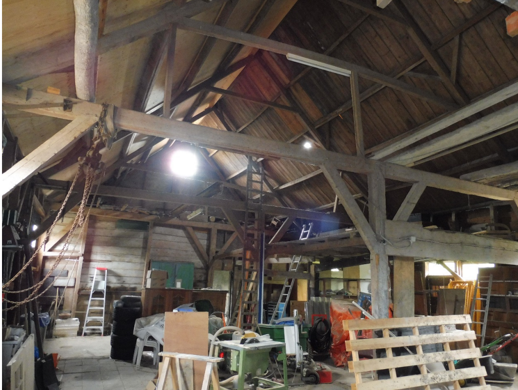
7: schuurinterieur richting oosten
