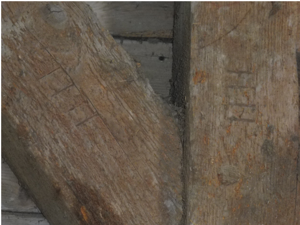
8: montage merken op de gebinten
