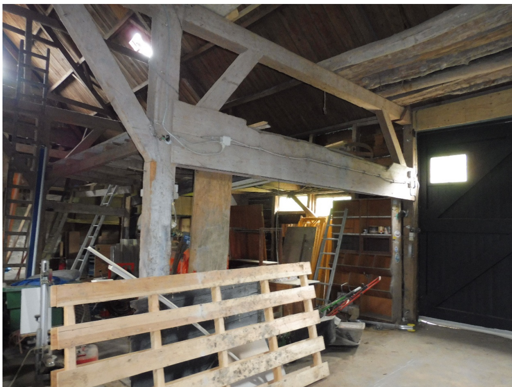
15: restant stallen met zoldertje in de 2 de en 3 de travee, zuidzijde
