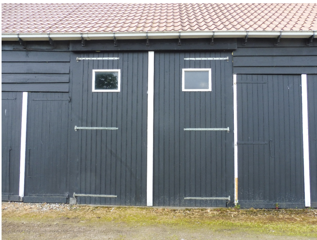
35: noordgevel, mendeurstel vierde travee
