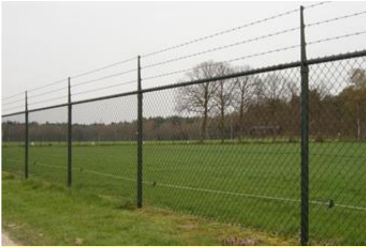
Figuur 2.5 Voorbeeld van een hekwerk rond het park
