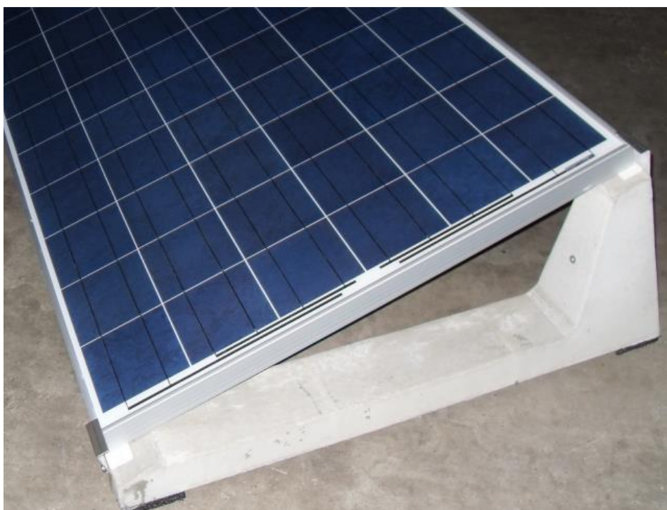
Figuur 20 Beeld van de constructie en wijze van fundering
