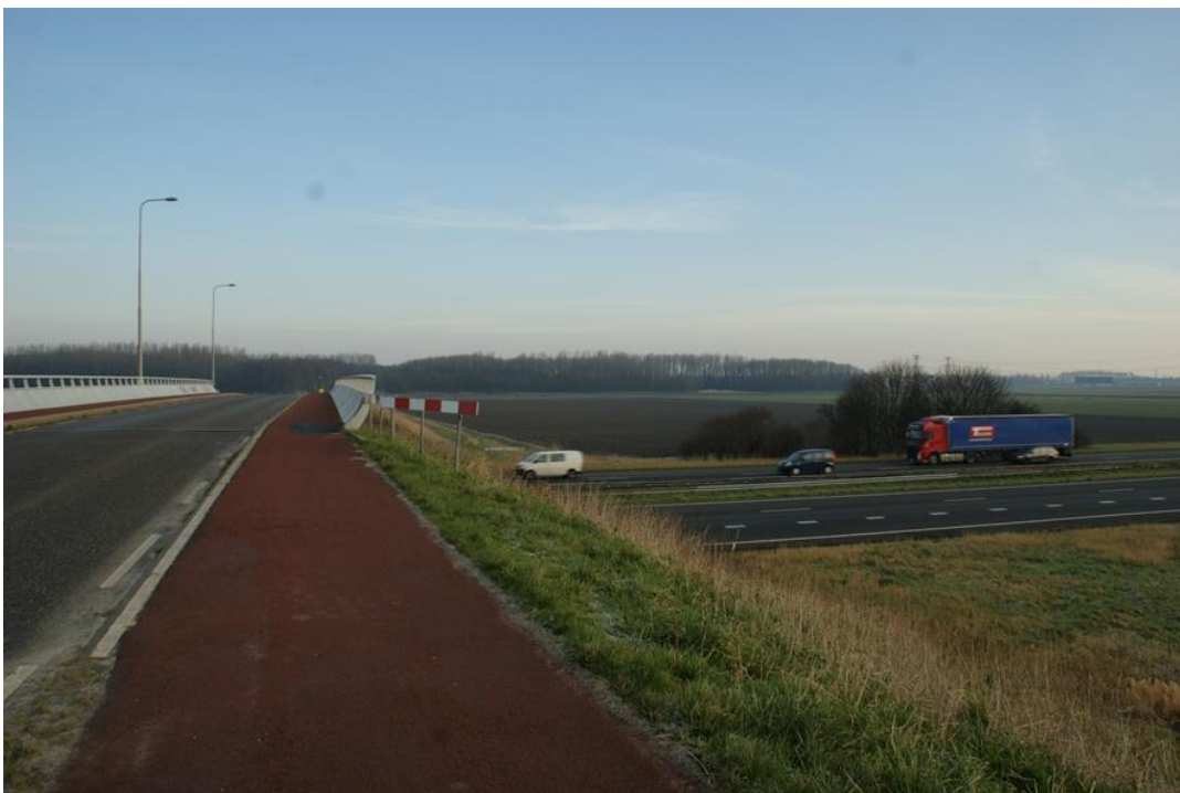
Figuur 16 Beeld van het viaduct over de snelweg
