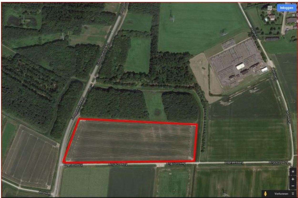
Figuur 1 Ligging plangebied van het zonnepark HVS Goes direct grenzend aan het Poelbos
