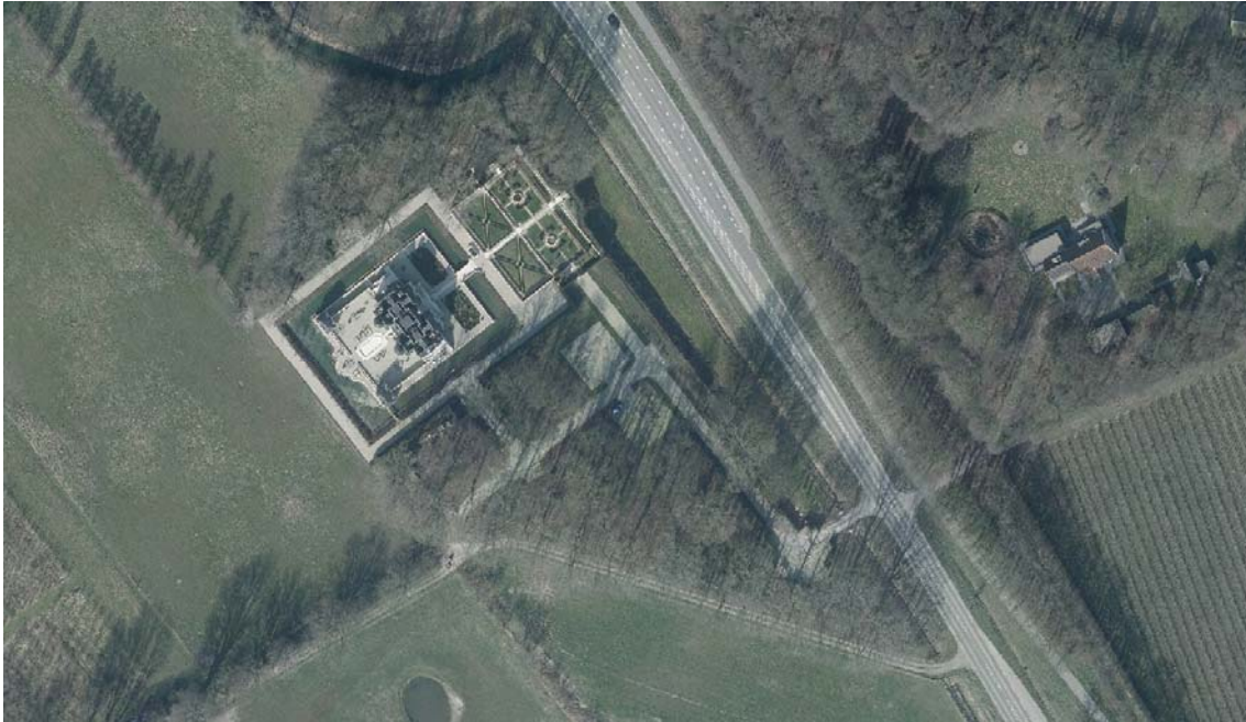
Figuur 1.2: Luchtfoto projectgebied (bron: Geoweb Zeeland)
