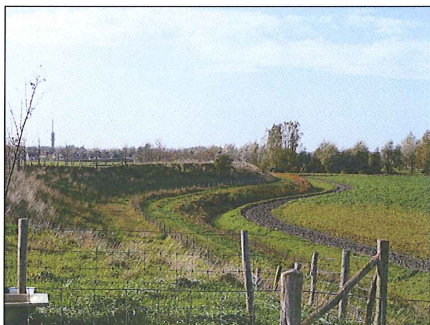
Fotonummer: 9 Omschrijving: Kattendijksedijk westelijke richting. Eindpunt van beide varianten.
