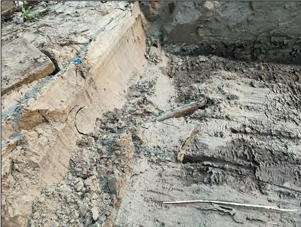
Foto 7: Leidingwerk richting voormalig ontluchtingspunt
