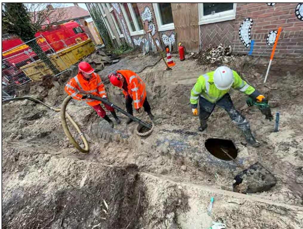
Foto 3: Inhoud HBO-tank verwijderen middels zuigwagen, zie fotorichtingen in tekening in bijlage 2
