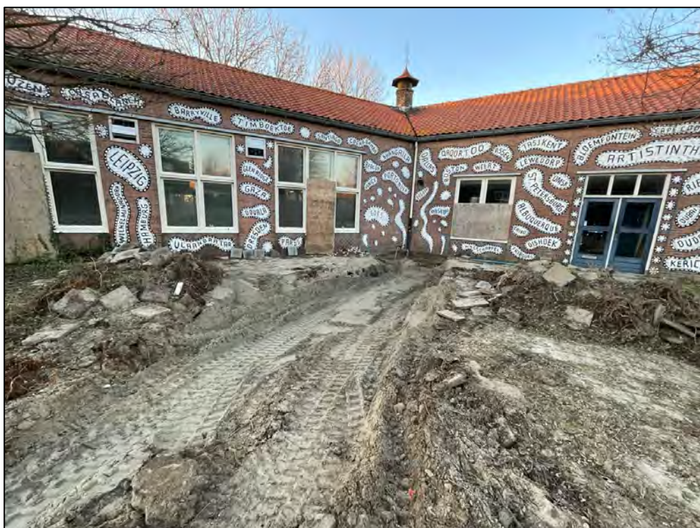
Foto 6: Eindsituatie na deels aanvullen met zand op 15 december 2022, zie fotorichtingen in tekening in bijlage 2
