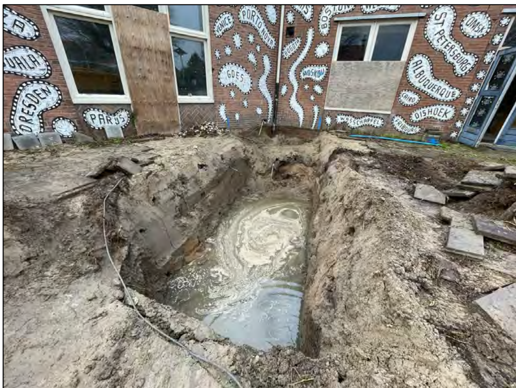
Foto 5: Ontgravingsput na uitvoeren bodemsanering, zie fotorichtingen in tekening in bijlage 2
