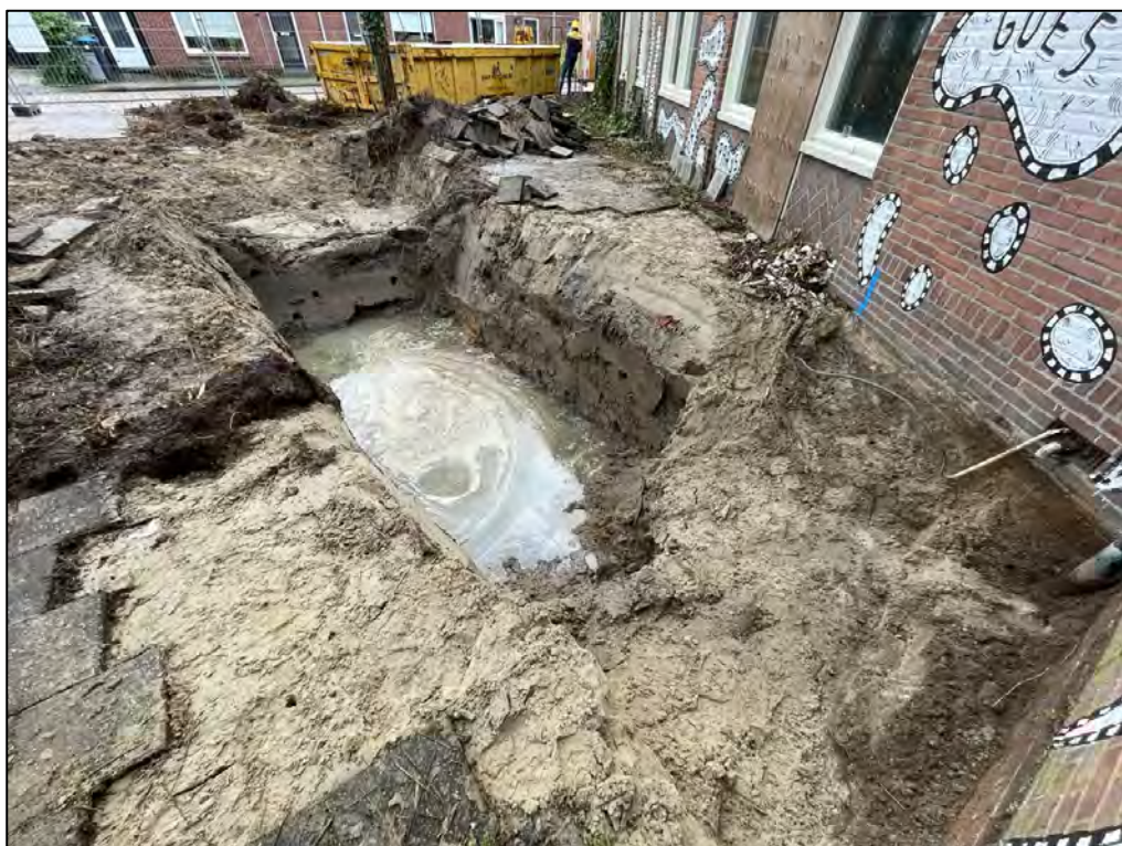
Foto 4: Ontgravingsput na uitvoeren bodemsanering, zie fotorichtingen in tekening in bijlage 2
