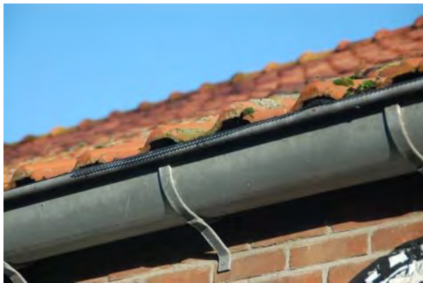
Figuur 6: Boven de dakgoot is ruimte onder de pannen waar doorgaans huismussen kunnen broeden. Op de linkerfoto is werend gaas aangebracht (westgevel).
