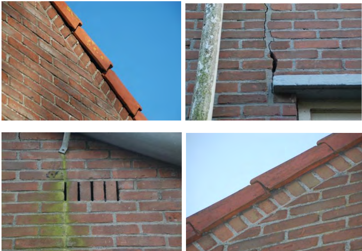
Figuur 8: Mogelijke verblijfplaatsen voor vleermuizen in het gebouw van het voormalige dorps huis.
