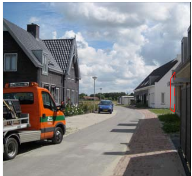
De Fluitweg met bouwstraatverharding, gezien vanuit het westen. De bouwlocatie ligt rechts van het witte huis.
