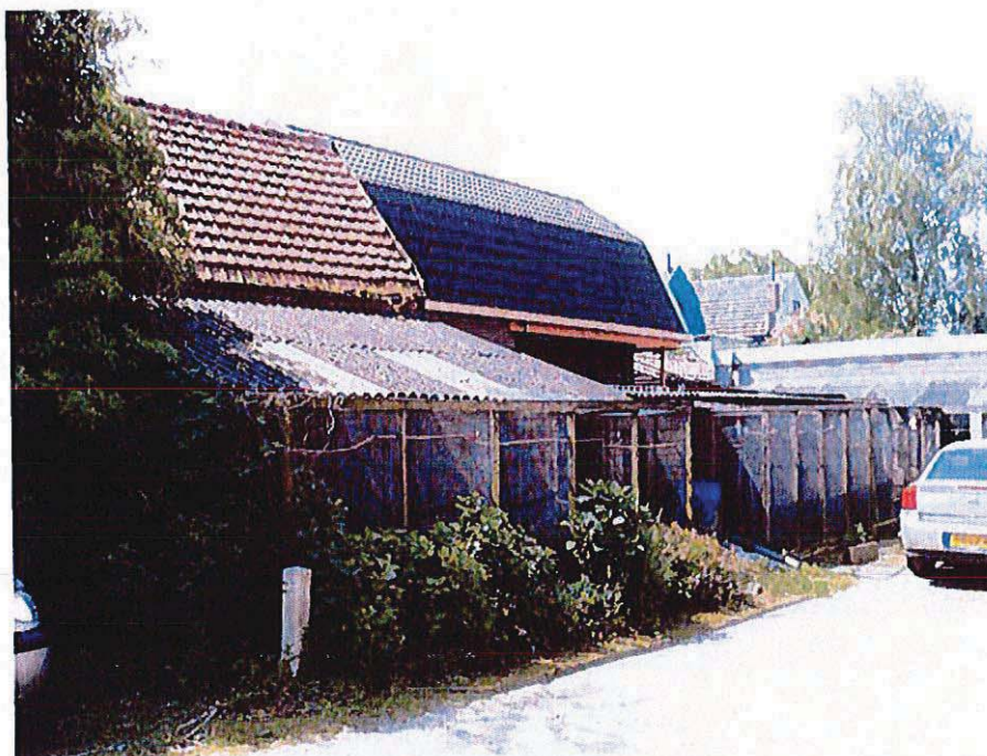
Foto 5: Overzichtsfoto oostelijk terreindeel langs zuidelijke perceelsgrens.
