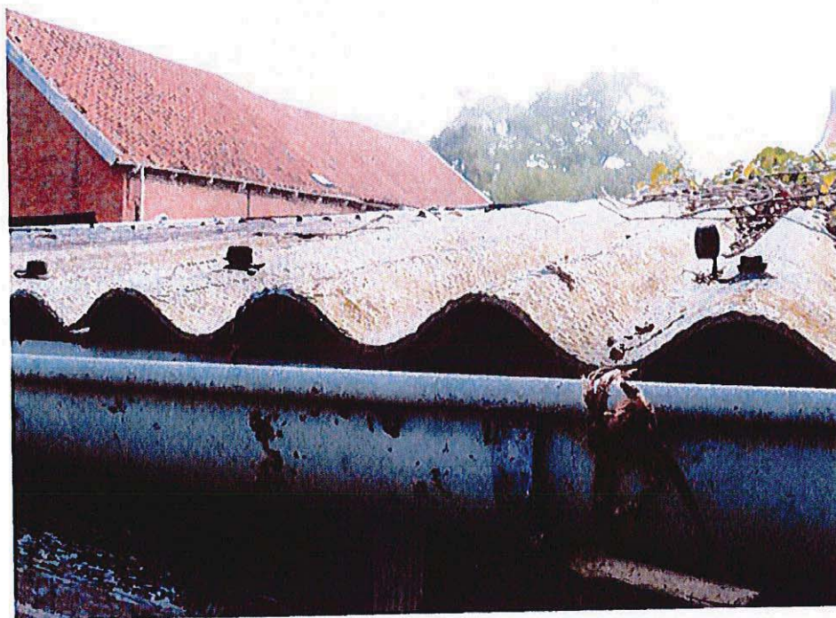
Foto 8: Close-up asbestgolfplaten op dak hangar.
