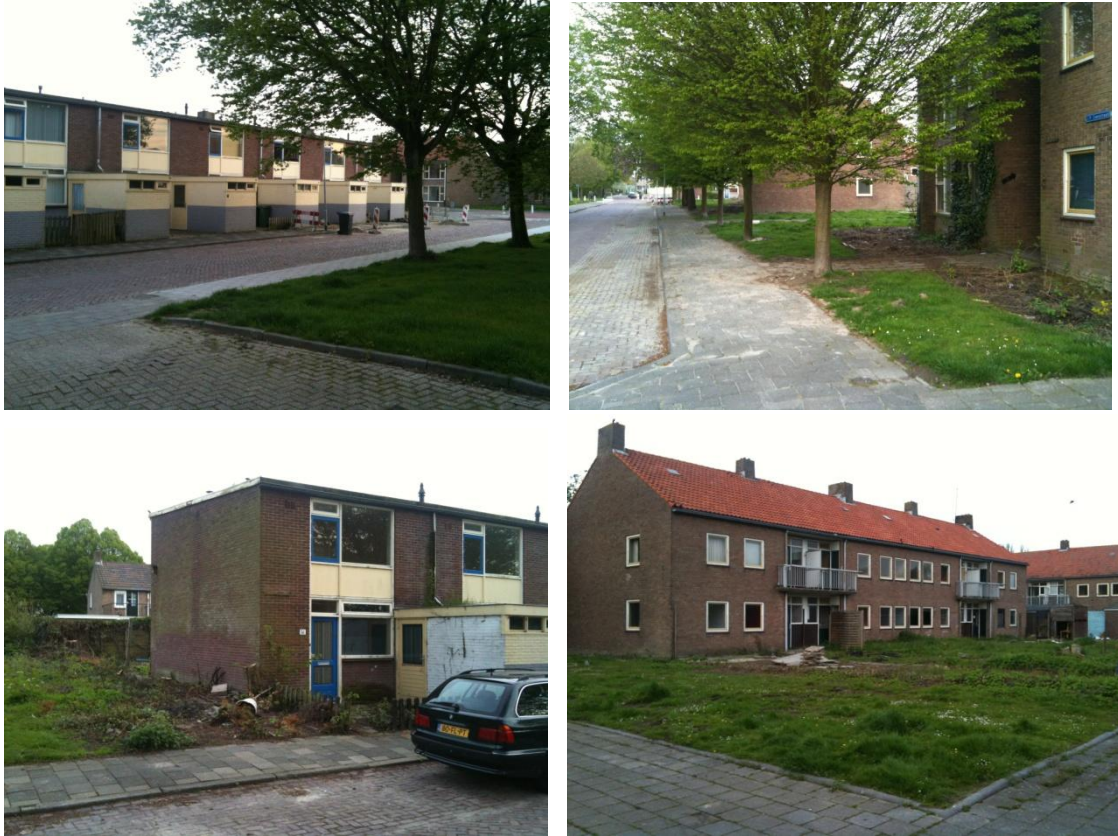
Figuur 1.3. Te slopen woningen J.P. Coenstraat
