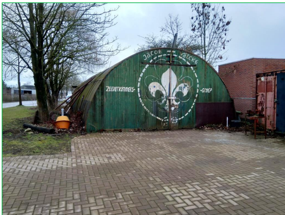
Foto 2 Locatie in zuidelijke richting, rechts locatie peilbuis
