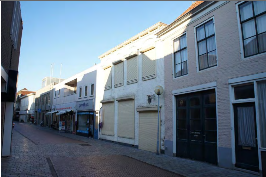
Figuur 4: Huidige voorgevel Wijngaardstraat
