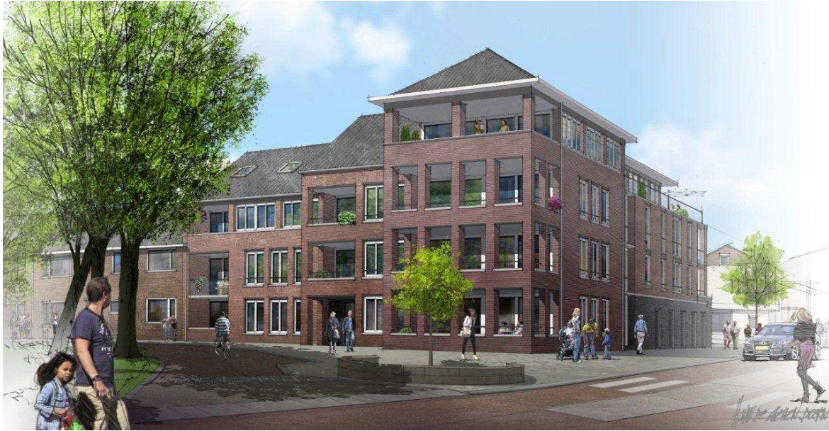
Figuur 6: kloeke gevel aan de hoek Oostsingel/Voorstad
