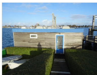
Figuur 2.5 Het toiletgebouw.
