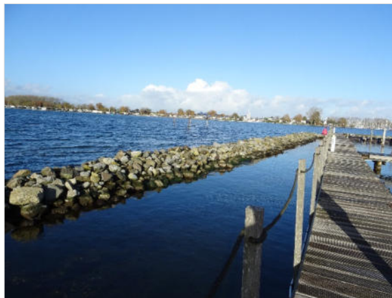
Figuur 5.3 Golfbreker van keien op de onderzoekslocatie.
