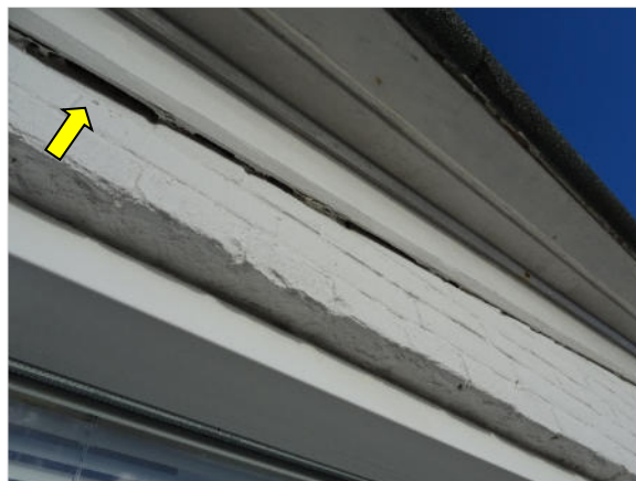
Figuur 5.2 Ruimtes achter de betimmering.
