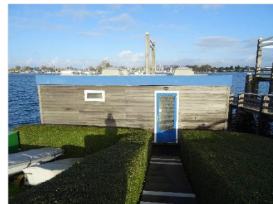
Figuur 2.5. Het toiletgebouw.
