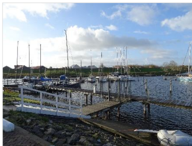
Figuur 2.3. Aanlegsteiger bij de ligplaatsen.
