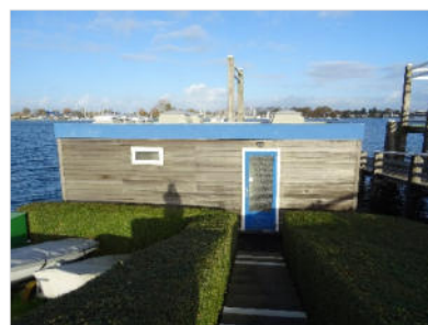
Figuur 2.3 Het toiletgebouw.
