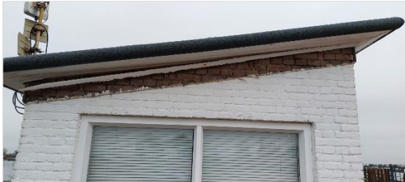
Figuur 3 Jachthuisje met betimmering verwijderd.
