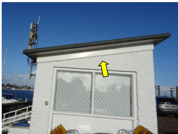
Figuur 5.1 Betimmering waarachter ruimte voor vleermuizen aanwezig is.
