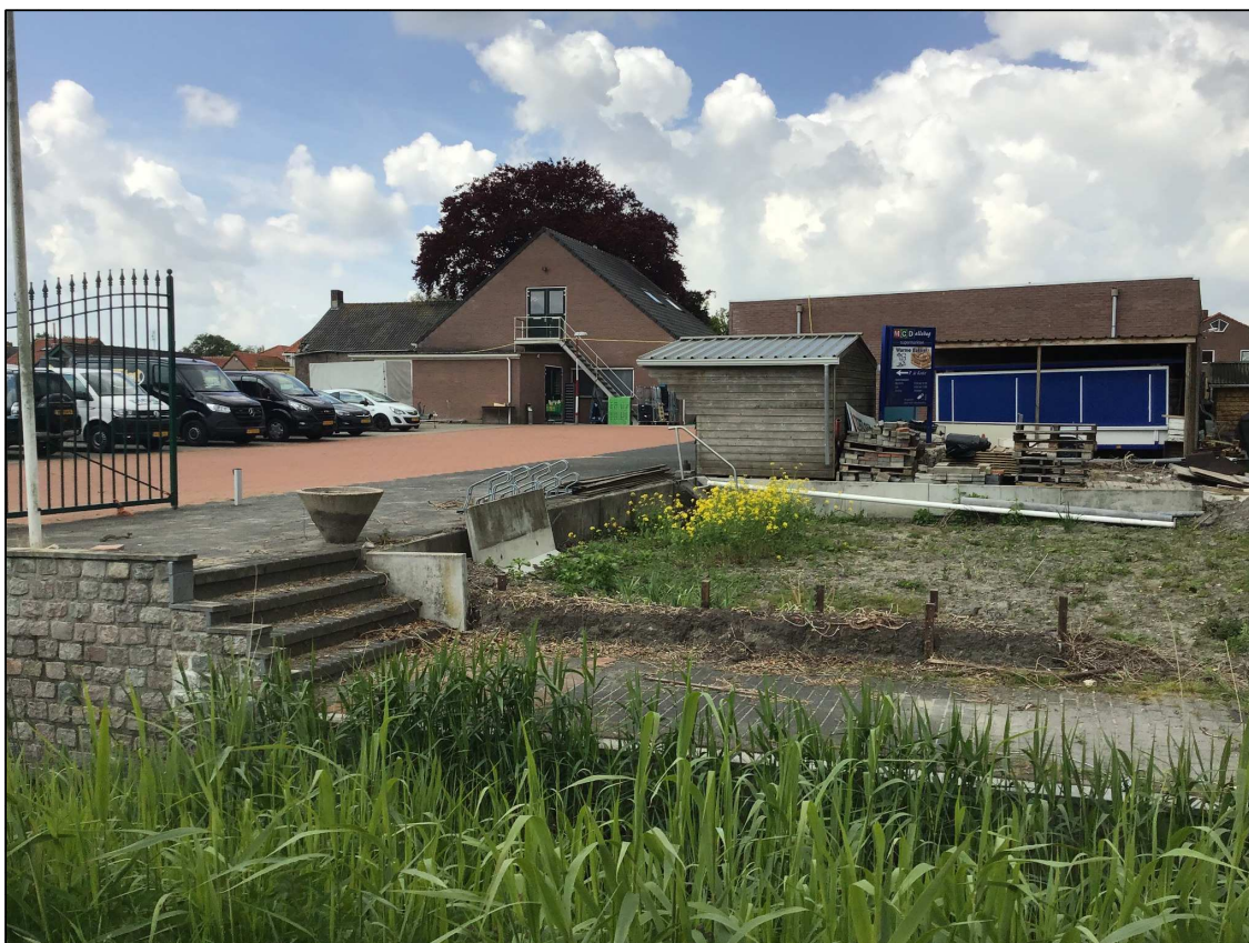
Foto 10: parkeerplaats met rechts nieuwbouwwak deellocatie 2
