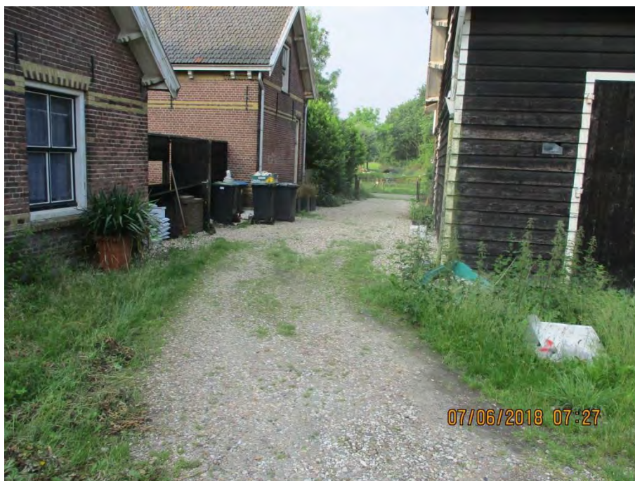
Verharding van grind op asfalt
