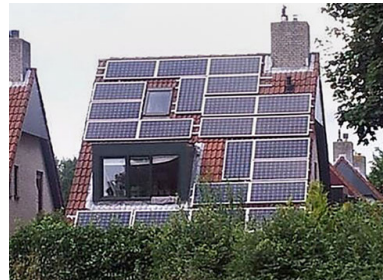
Figuur 31: Zonnepanelen zorgen voor een rommelig dakvlak
