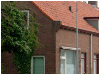
metselwerk ornamentering: beeindiging goot met oor
