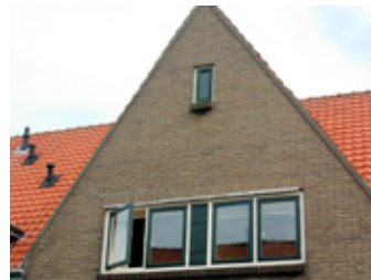
metselwerk ornamentering: rollaag + afgesmeerde pan
