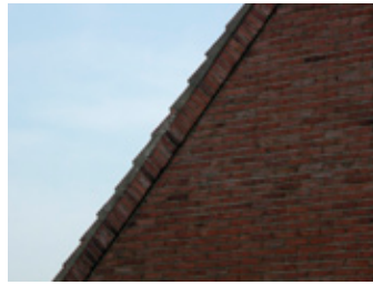
metselwerk ornamentering: rollaag + afgesmeerde pan
