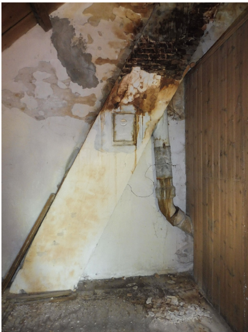
55: rookkanaal tegen de zuidgevel met rechts het kanaal vanuit de linker achterkamer
