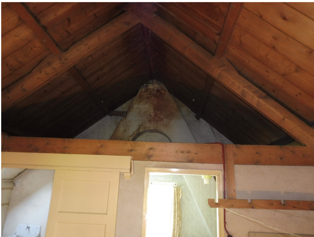
53: rookkanaal tegen de rechter / noordelijke zijgevel
