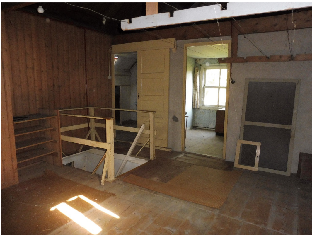
56: zolder richting noordwest hoek met trap opgang
