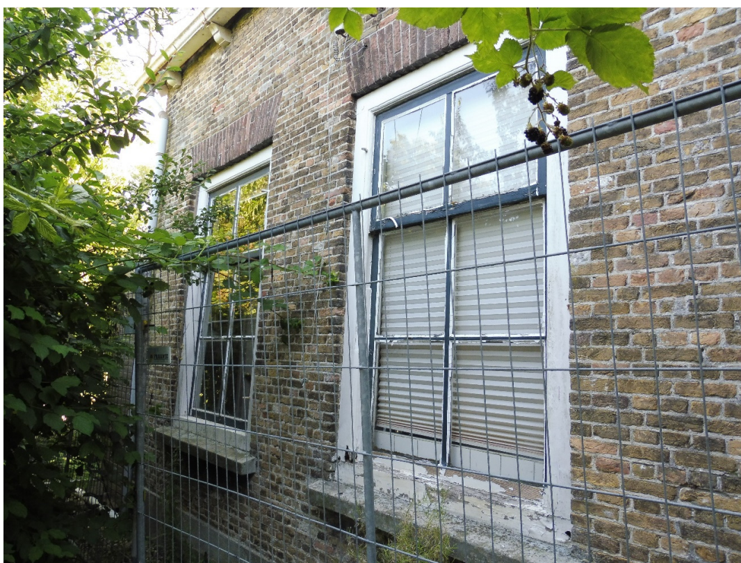
30: achtergevel, noordelijk gedeelte
