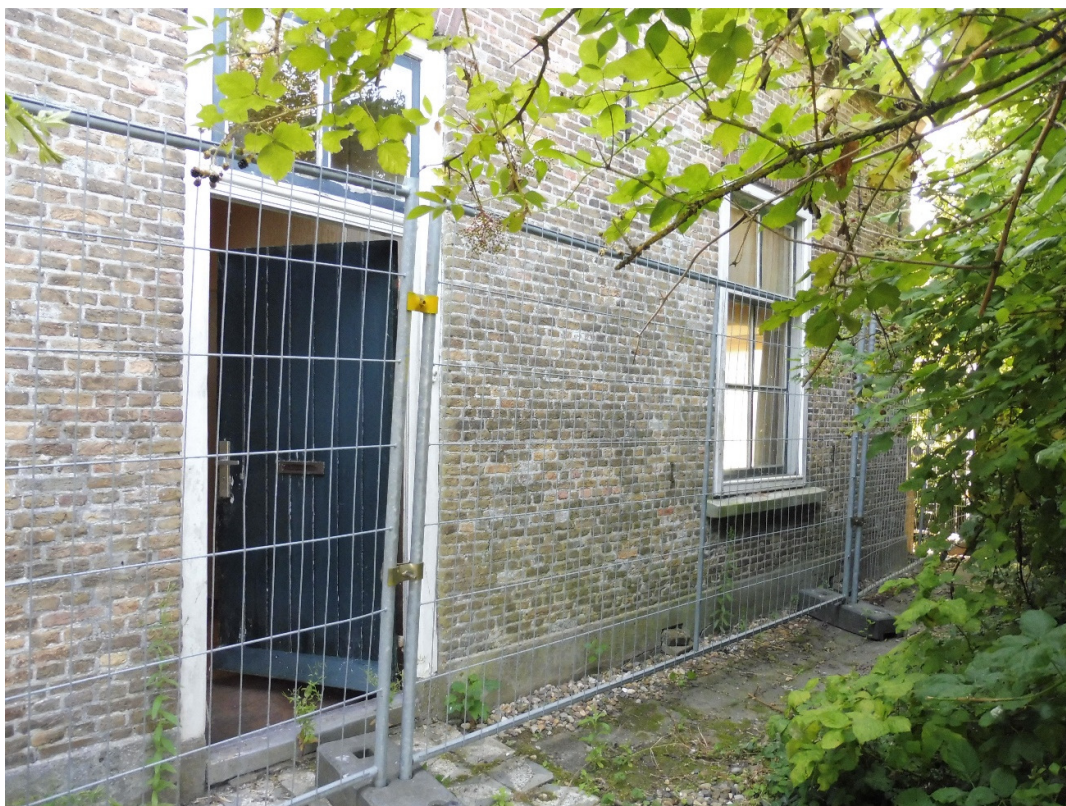
29: achtergevel, zuidelijk gedeelte en achterdeur
