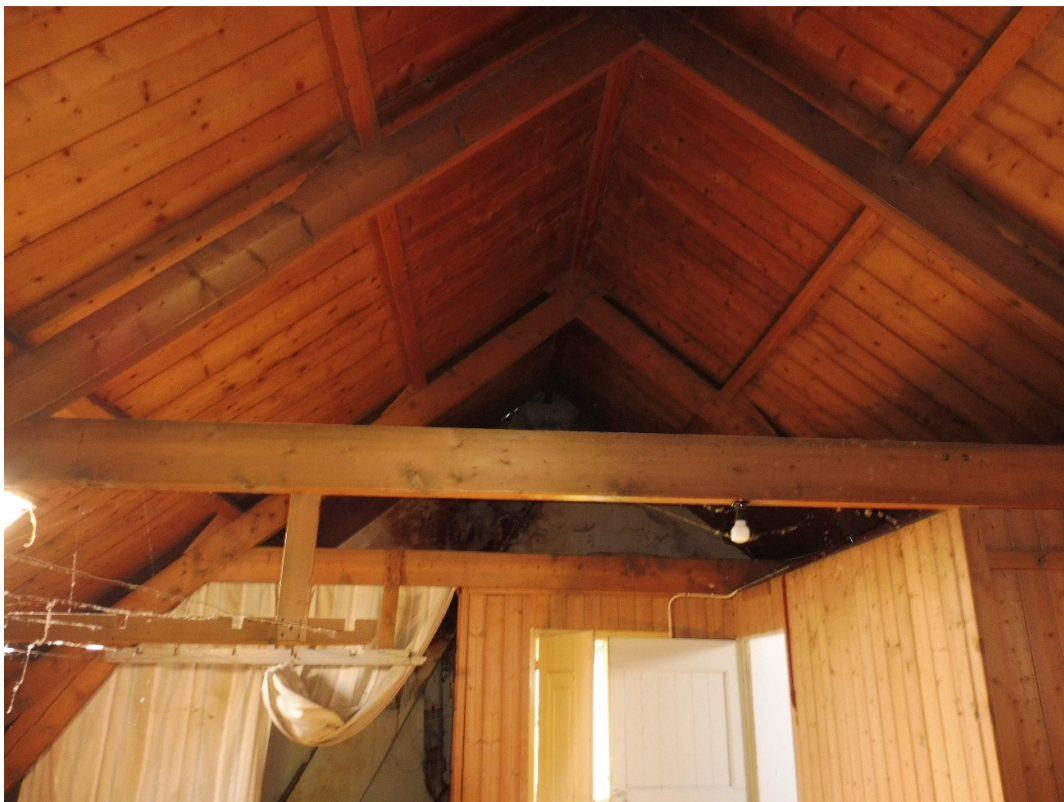
52: kapconstructie richting zuidgevel
