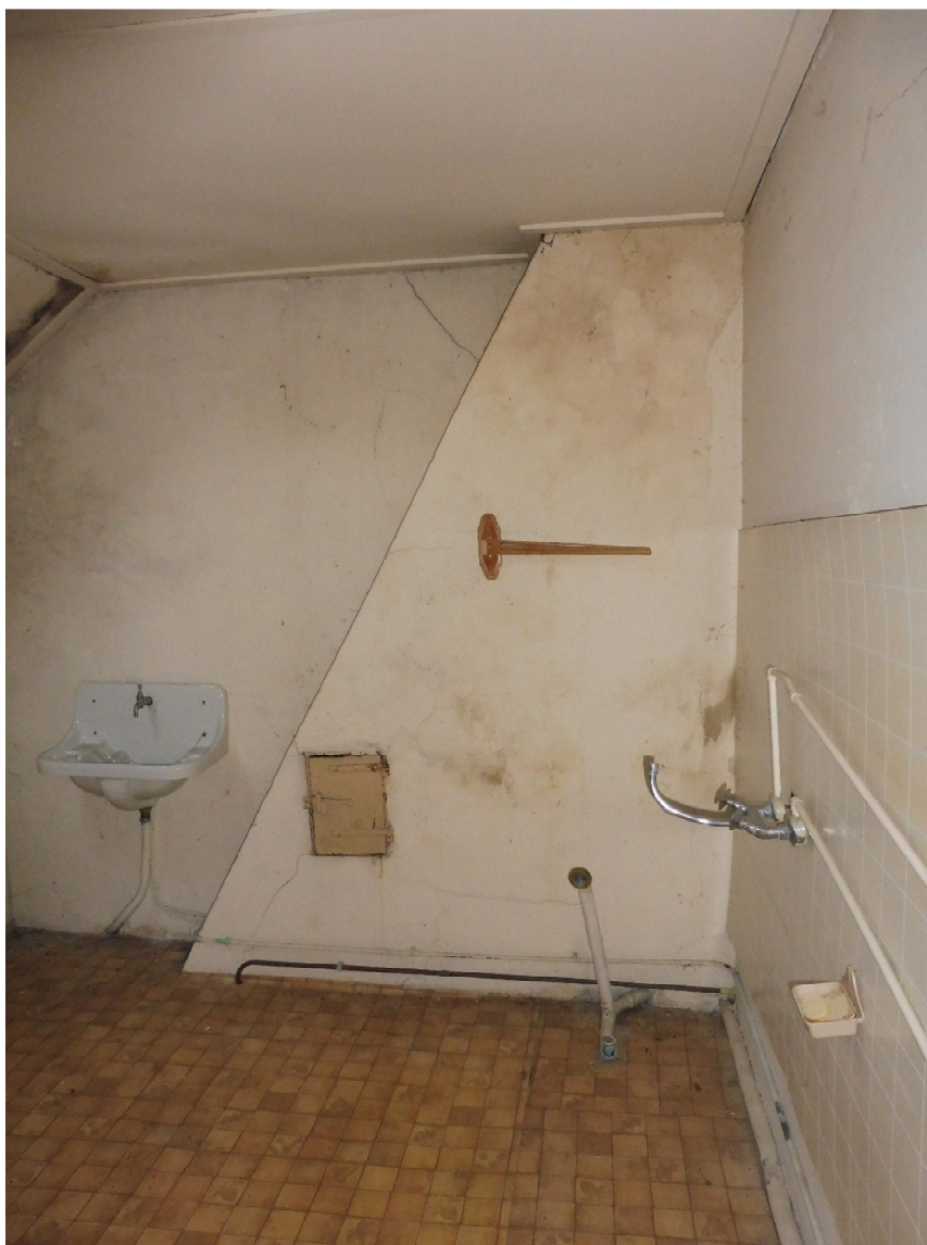
54: rookkanaal boven de keuken aan de noordgevel
