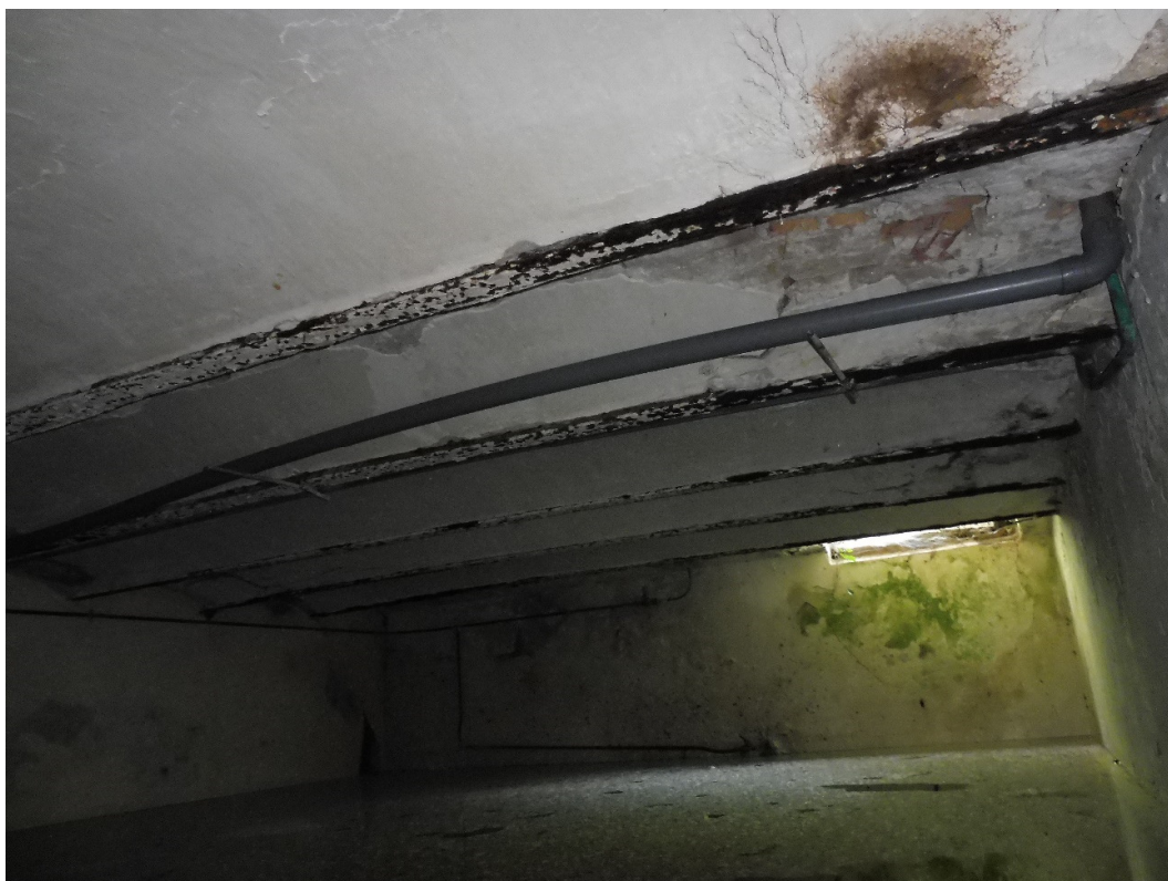
50: kelder plafond met troggewelven
