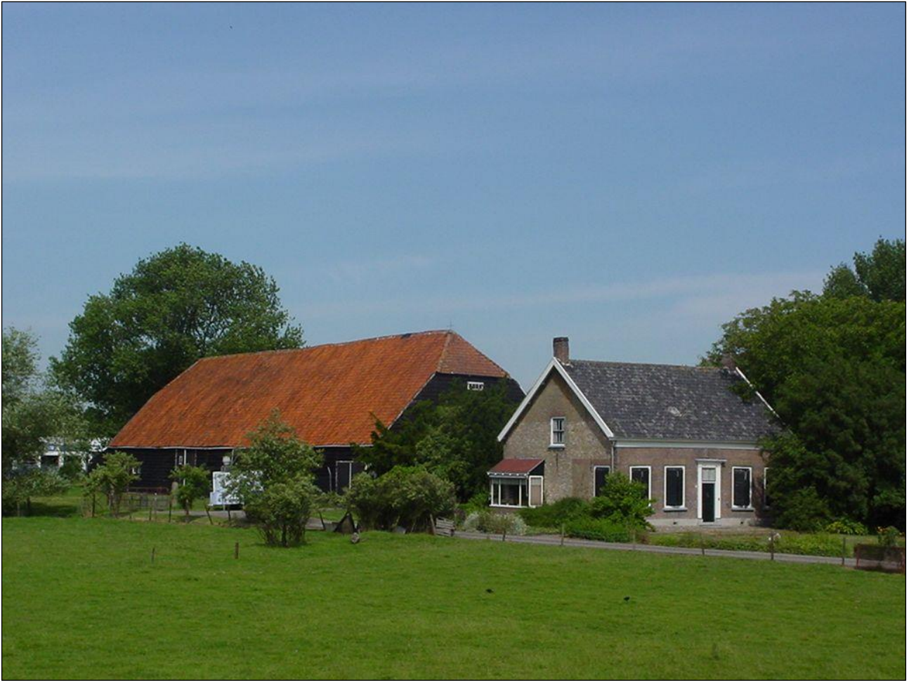
Figuur 16 Foto van de bebouwing in het plangebied vóór de brand in 2009. Links de 19 de -eeuwse schuur die verloren is gegaan. Bron: Geoloket Cultuurhistorie Provincie Zeeland.
