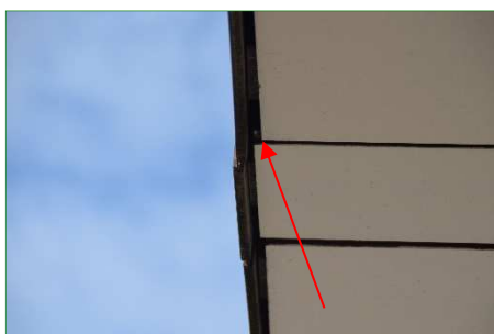
Locatie 4: kieren in de beplating in de dakrand aan de zijde met de parkeerplaats.
