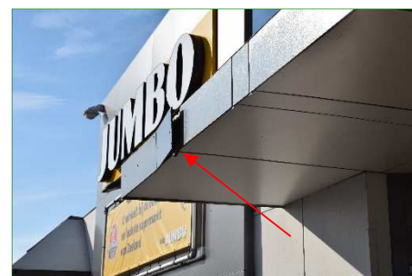
Locatie 4: kieren in de beplating in de dakrand aan de zijde met de parkeerplaats.
