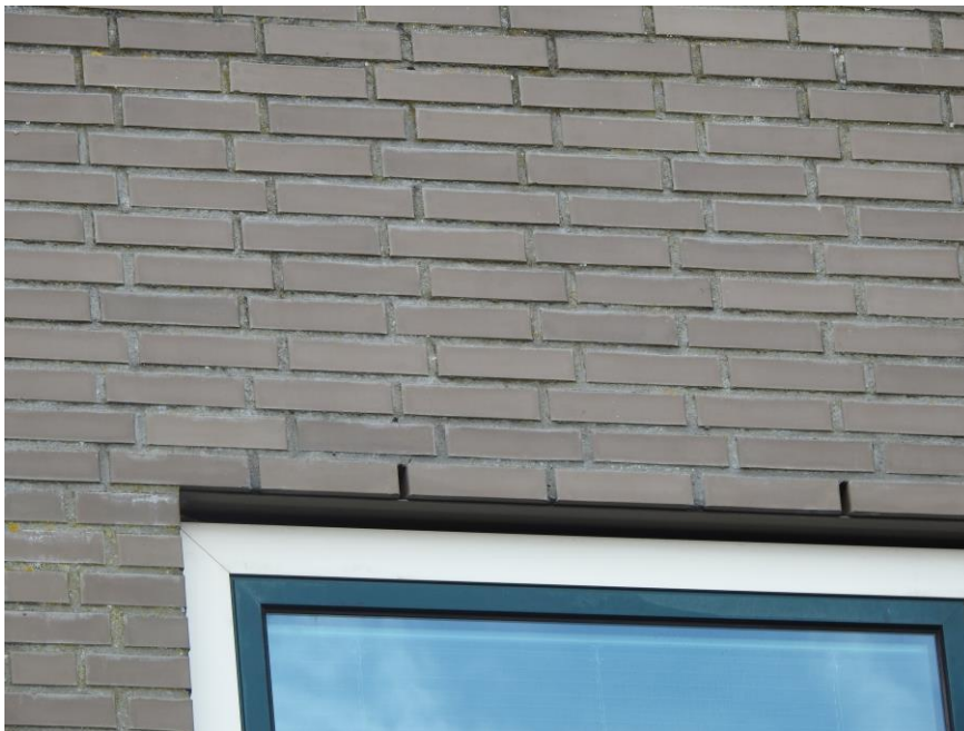
Foto 2. Open stootvoegen (mogelijkheden voor vleermuizen).
