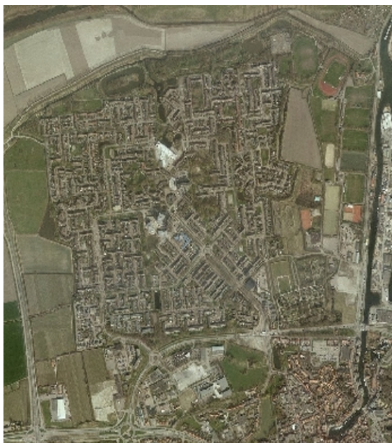
Figuur 1: luchtfoto Goese Polder
