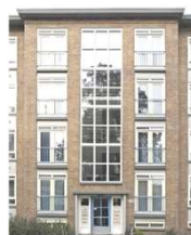
Landelijke voorbeelden wederopbouw. Aandacht voor details Dakrand, gevelopeningen, gevelbanden, balkons en entrees. Repetitie en spiegeling. Metselwerk als herkenbaar basismateriaal
