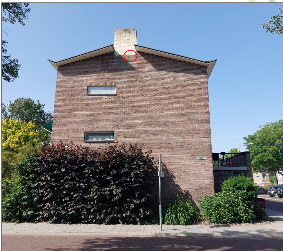
Eén van de kopgevels van de complexen binnen het plangebied. Groeiplaatsen van muurvaren zijn aanwezig (rode cirkel). Het groen rondom het complex is geschikt als leefgebied voor huismus. Foto: M.W.H. Bekkers en L. Boon | Ecoresult B.V.
