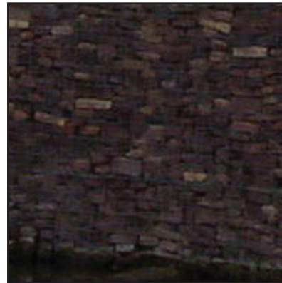
schanskorven met gestapelde baksteen
