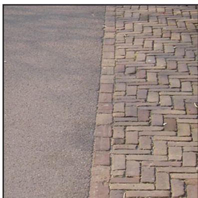
asfalt en gebakken materiaal 'koud' tegen elkaar.
