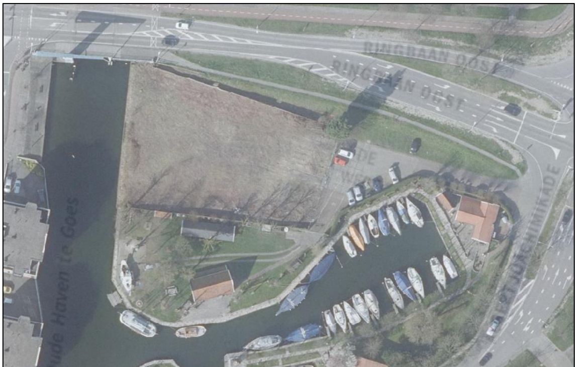
Luchtfoto plangebied met ontsluitingsweg en parkeren jachthaven aan oostzijde perceel
