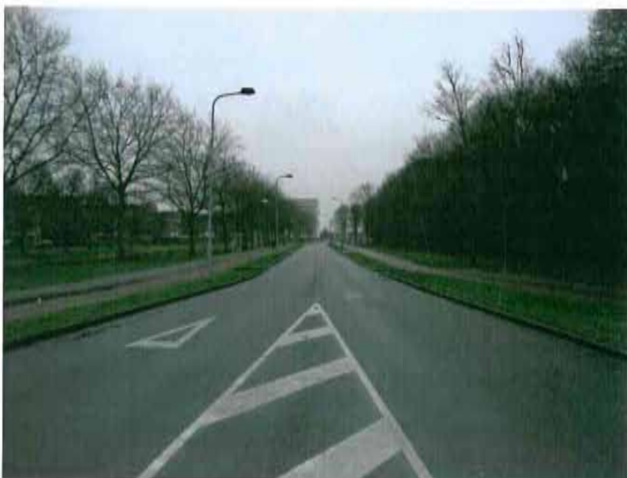
Foto 742: Van Hertumweg gezien in zuidelijke richting
