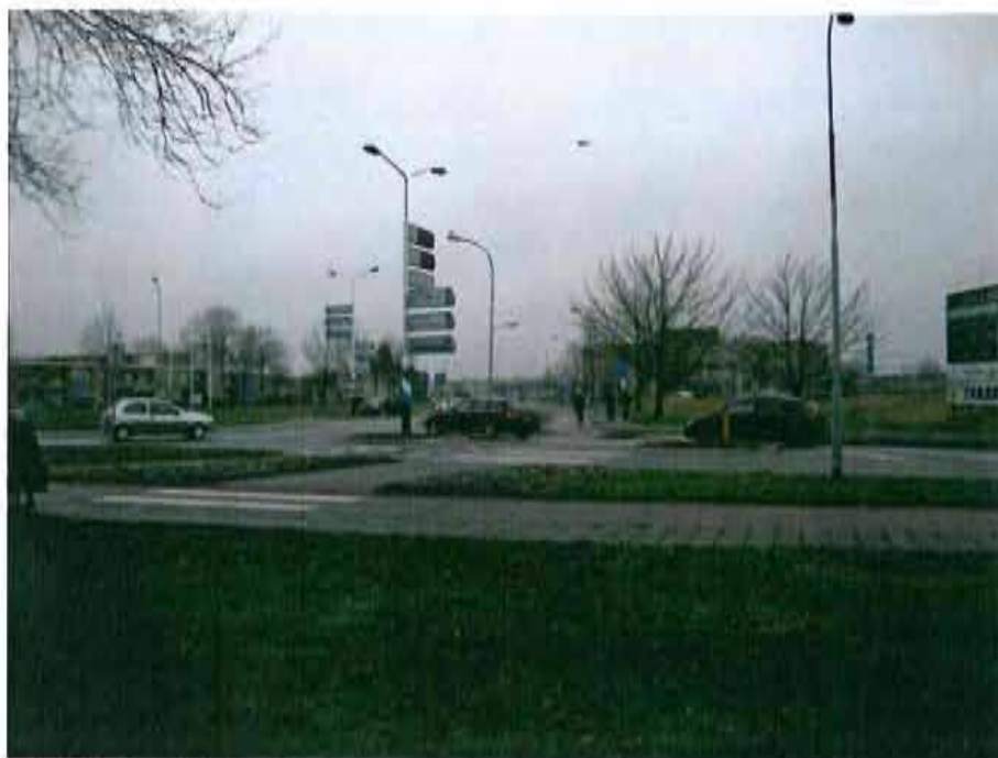
Foto 739: Poelplein/Van Hertumweg gezien in noordwestelijke richting
