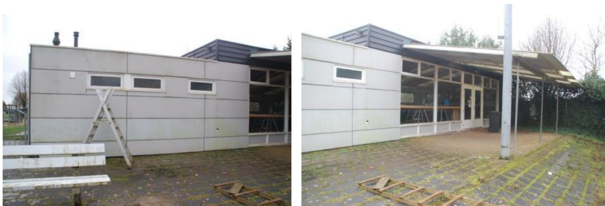
Afbeelding 5 t/m 8: het gebouw is volledig bedekt met metalen (zwart) en trespas (wit) panelen. Het gebouw is vrijwel hermetisch afgesloten
