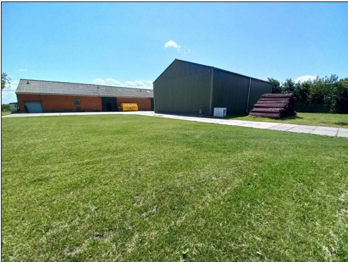
Figuur 1.2.: De te slopen schuren in het plangebied.
