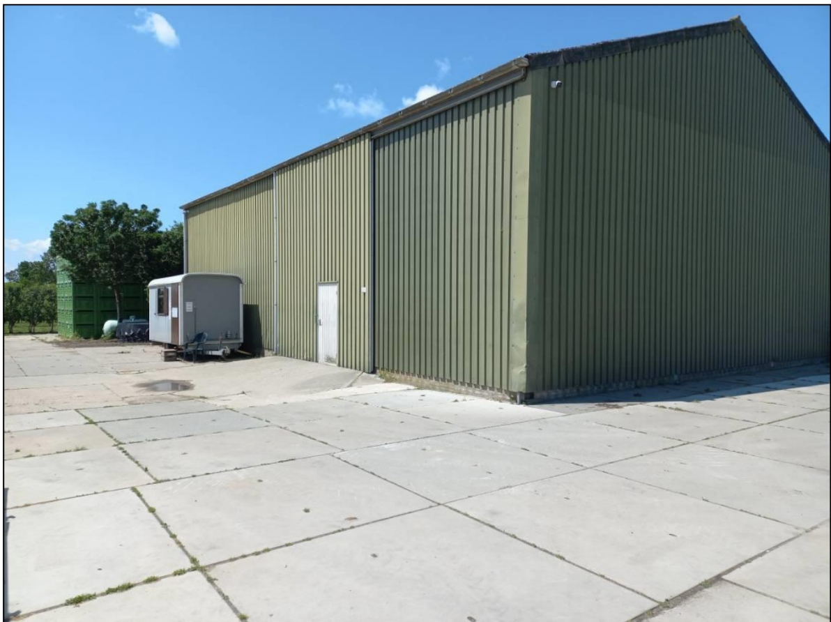
Figuur 2.2.: in de hoogste schuur in het plangebied is geen nestgelegenheid voor vogels aangetroffen.
