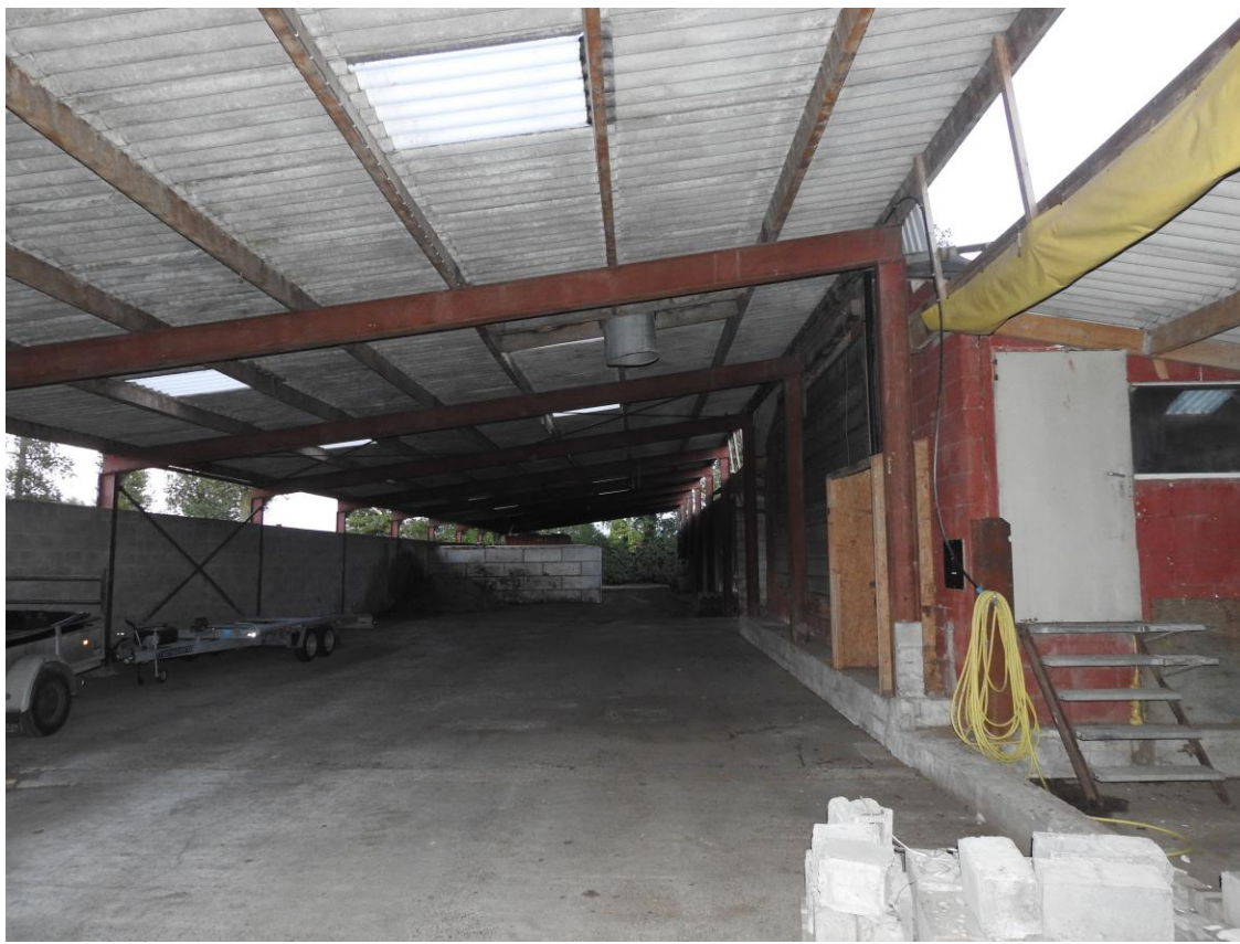
Foto. 3 Te slopen bebouwing.
