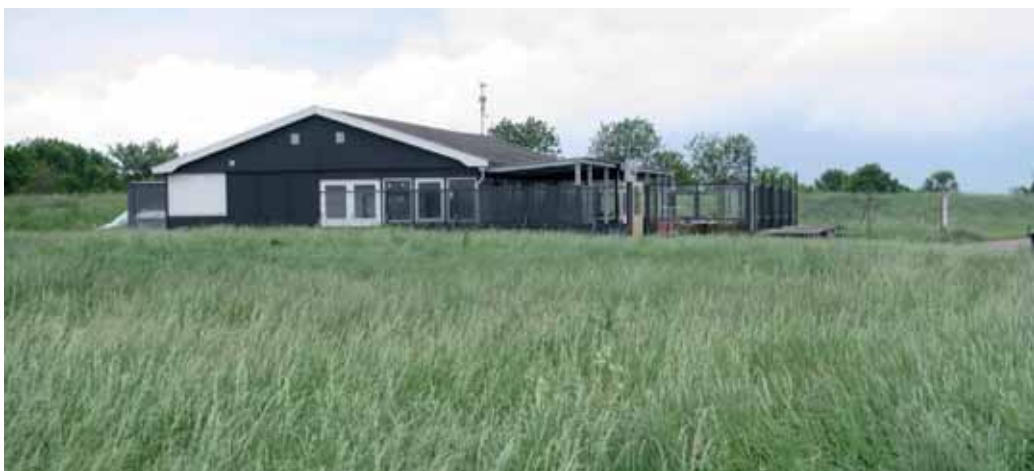
Figuur 2.2 Het huidige strandpaviljoen De Landing, met op de voorgrond een deel van de nol.
